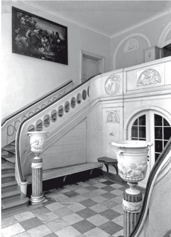
Treppenhaus von 1771 und ca. 1840
