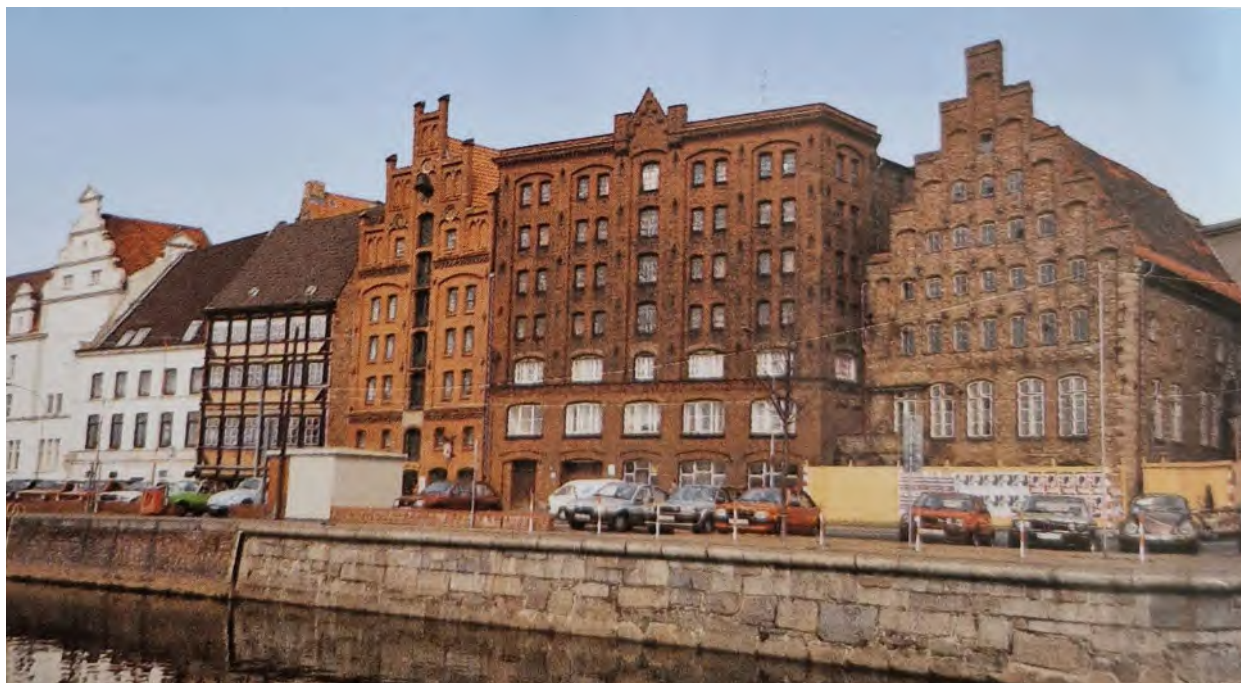
Abb. 1 Lübeck. Das imposante Speichergebäude An der Untertrave 98 von 1870; rechts das Saalgeschosshaus Alfstraße 38 von 1220, links der ehemalige Posschl'sche Speicher Nr. 97 von 1871.
