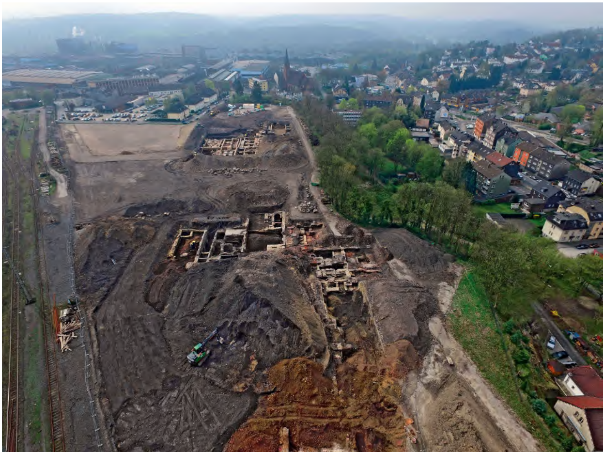
Abb. 3.1 Witten, Steinhauser Hütte, Übersicht. Blick von Norden auf die Fläche des Gewerbegebiets „Drei Könige“. Hinter dem Plateau mit teilweise aufgedeckten Überresten der Steinhauser Hütte liegt ein noch produzierendes Edelstahlwerk (Foto: Schmidt-Rutsch / Essling-Wintzer 2020, 103 Abb. 2).
