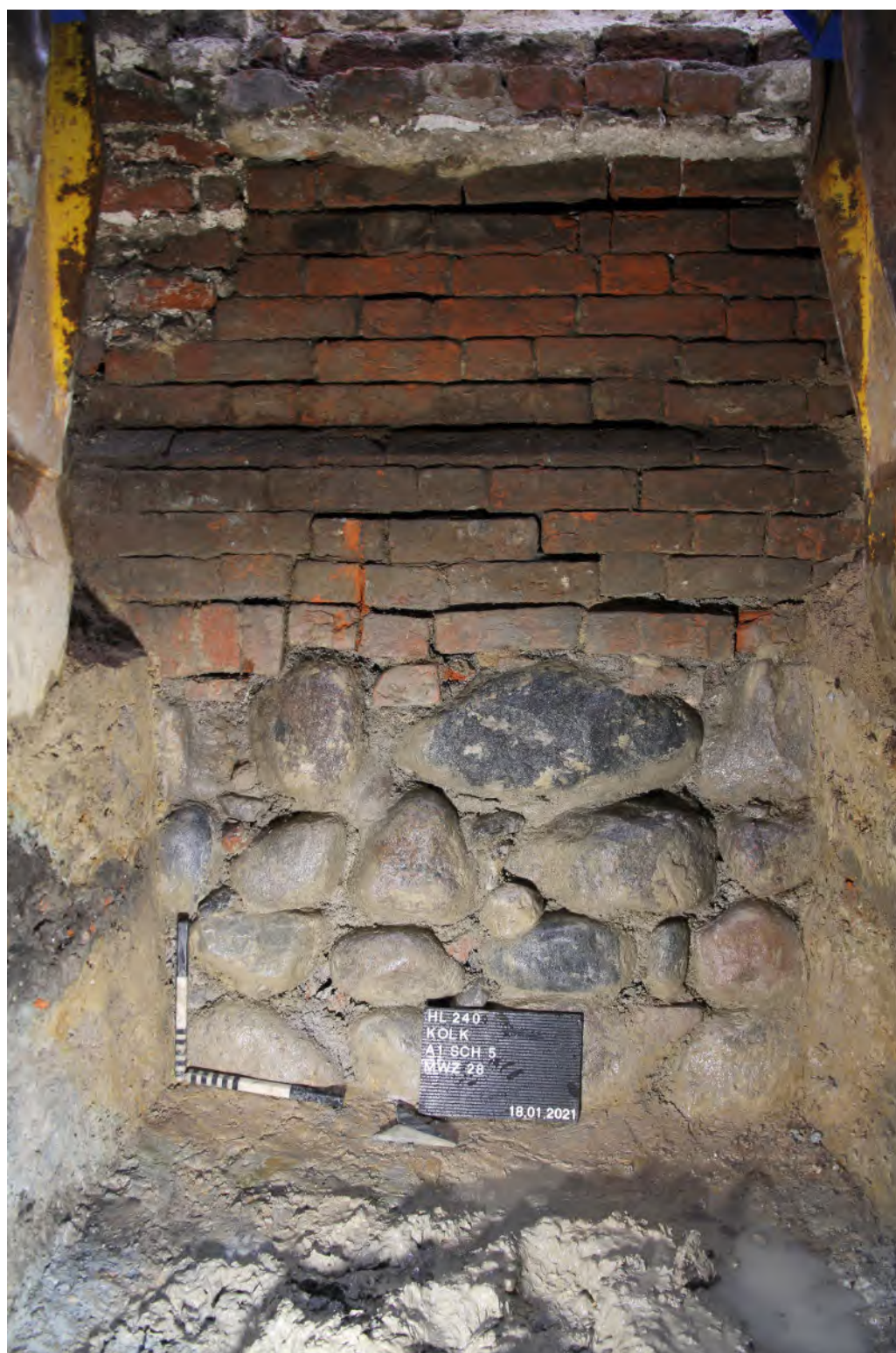
Abb. 7 Steinwerk Kolk 14, Findlingsfundament und Sockel aus abgeschrägten, scharrierten Backsteinen (Foto: K. Siegfried, Grabungsdokumentation HL 240).
