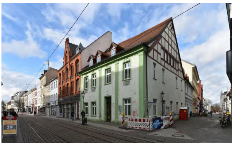
Abb. 1 Das Eckgebäude Hauptstraße, Ansicht von Süden 2023 (Foto: J. Müller).
