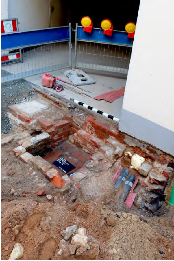
Abb. 11 Mehrfach verkleinerter und abschließend zum Lichtschart umgebauter Kellerabgang der Mengstr. 68. Stark durch einführende Rohrleitungen gestört (Bereich Archäologie und Denkmalpflege der Hansestadt Lübeck).
