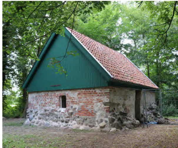
Abb. 18 Lübeck-Schönböcken, Der „Berchfried“ auf Gut Roggenhorst nach der Sanierung (Foto: Ingrid Sudhoff).
