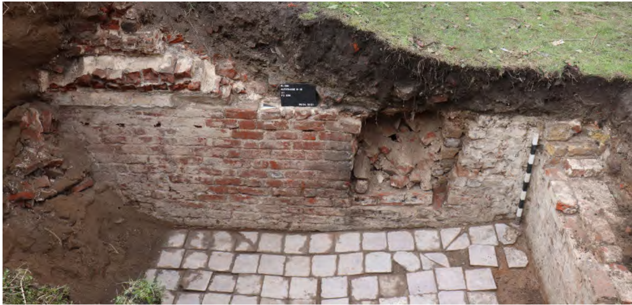
Abb. 6 Mauerdurchbruch in der mittelalterlichen Brand-/Kellermauer zwischen den Grundstücken Alfstraße 12 und 14 als Schutzmaßnahme vor Verschüttung im Falle eines Luftangriffs.
