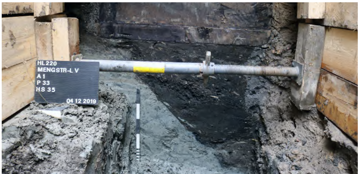
Abb. 3 Drainagegraben der Mengstraße mit Verfüllschichten, wird von einem Schwemmkasten des Drainagesystems überlagert (Bereich Archäologie und Denkmalpflege der Hansestadt Lübeck).
