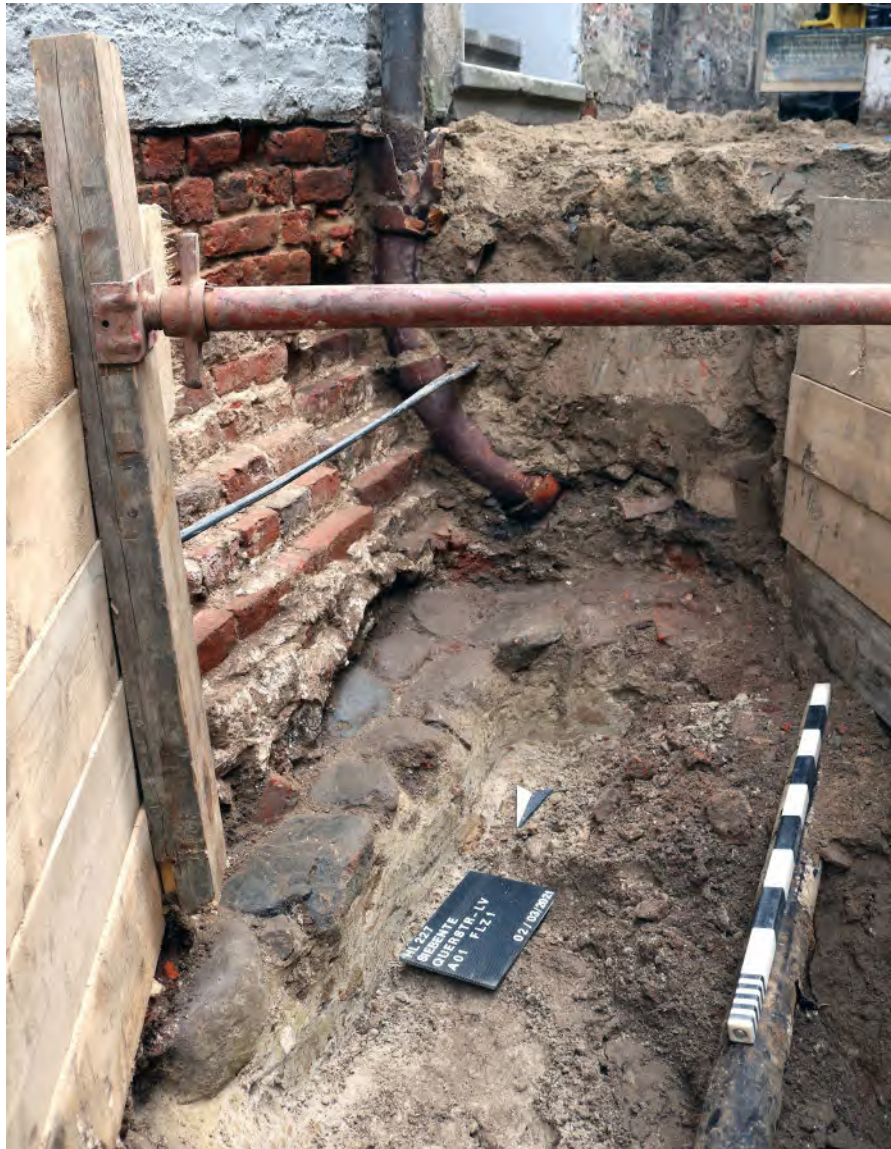
Abb. 13 Das Backsteinfeldament der Mengstr. 54 überlagert die Gosse der vierten Steinpflasterlage in der Siebenten Querstraße (Bereich Archäologie und Denkmalpflege der Hansestadt Lübeck).
