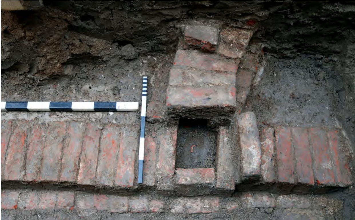
Abb. 10 Einführung eines Hausanschlusses in den Backsteinkanal (Bereich Archäologie und Denkmalpflege der Hansestadt Lübeck).
