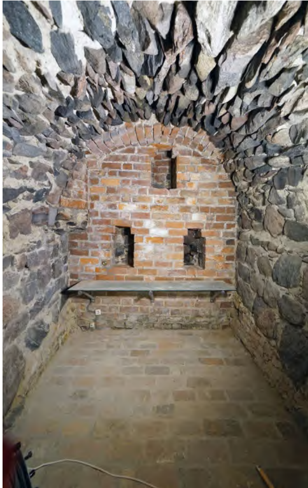
Abb. 8 Hauptstraße 9, Keller; Vorraum 4 mit Tonnengewölbe und spätmittelalterlicher Vermauerung. 2023 (Foto: J. Müller).
