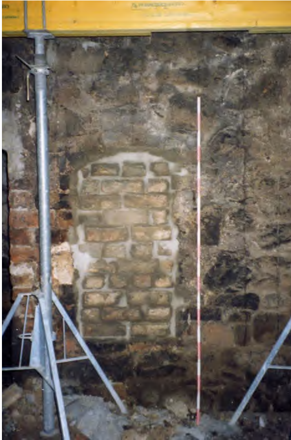
Abb. 6 Hauptstraße 9, Keller; Blick zur Nordwand mit vermauerter Tür (?) während der Bauarbeiten 1990/91 (Quelle: Metzler/Koppe 1991).
