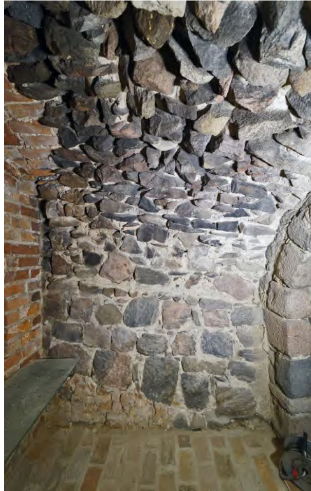
Abb. 9 Hauptstraße 9, Keller; Vorraum 4 mit Tonnengewölbe, nach Norden zur Straße ansteigend Fußboden, Kämpfer und Gewölbeseitel, links Ausbruch eines Bogens. 2023 (Foto: J. Müller).
