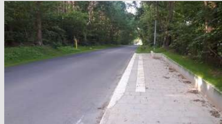
An den Schießständen – nach dem Umbau
