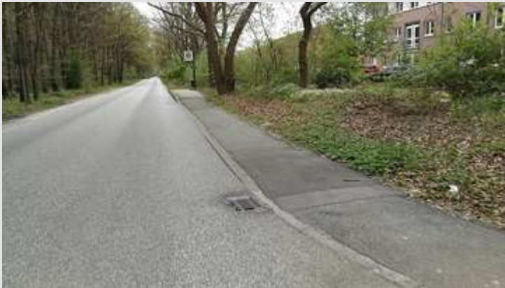
An den Schießständen – vor dem Umbau
