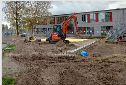
Baggerarbeiten auf dem Schulhof
