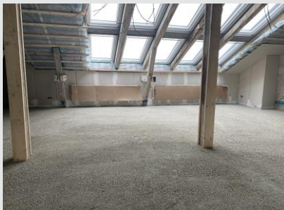
Dachgeschossausbau Einbau Trockenestrich
