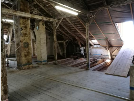
Dachgeschoss vor Ausbau
