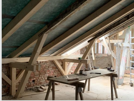
Dachgeschoss während des Ausbaus
