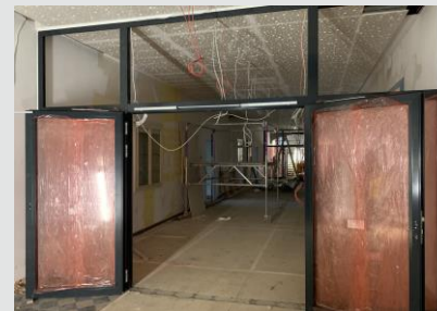
Blick in Flurbereich 1.OG
