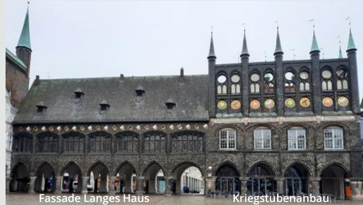
Fassade Langes Haus
