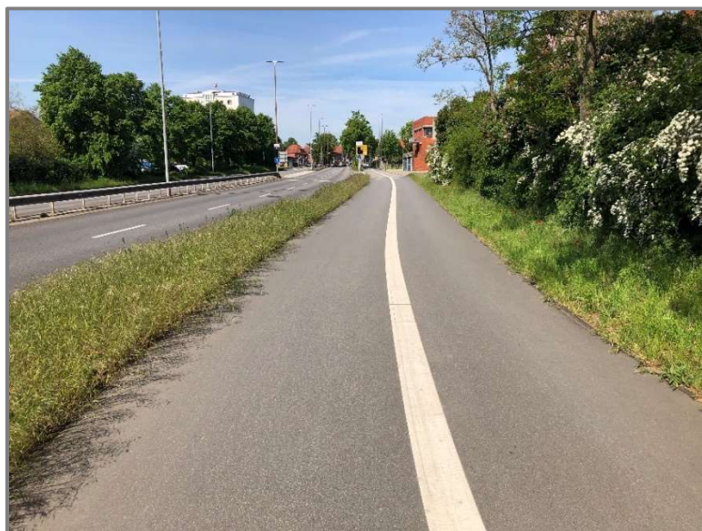
Abb: Sanierter Geh- und Zweirichtungsradweg Stockelsdorfer Straße
