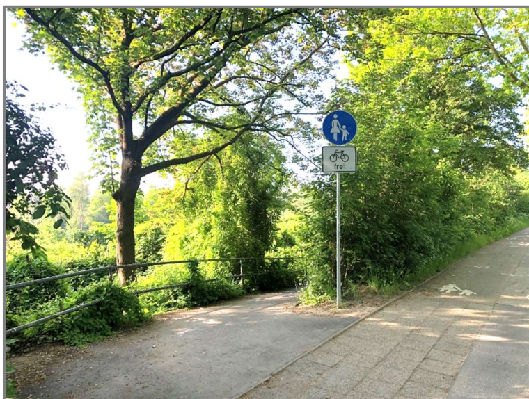
Abb.: Sanierte Rampe Wallbrechtbrücke
