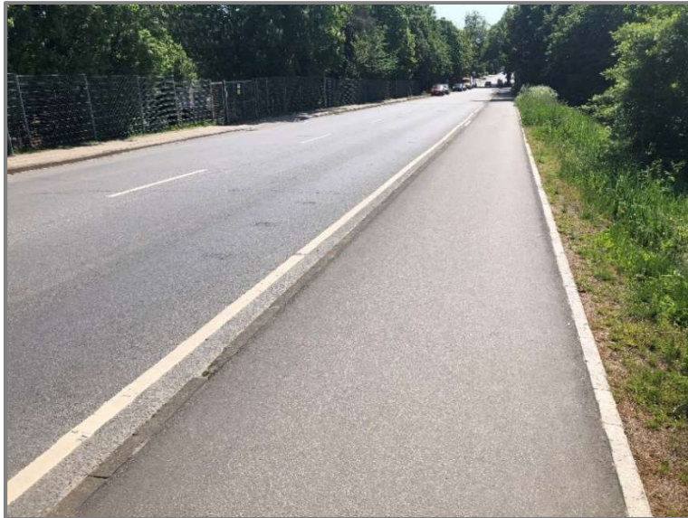
Abb.: Sanierter Geh- und Zweirichtungsradweg Vorwerker Straße
