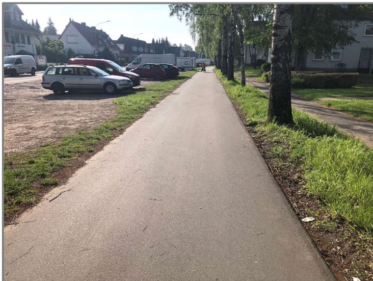
Abb.: Sanierter Zweirichtungsradweg Brandenbaumer Landstraße
