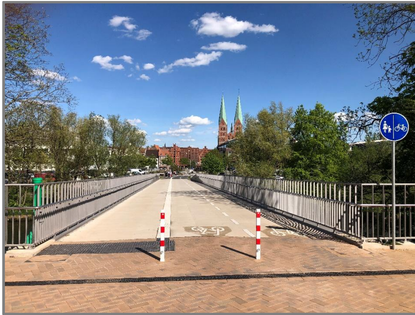
Abb.: Stadtgrabenbrücke für Fuß- und Radverkehr
