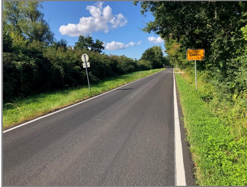
Abb.: Sanierung der Vorrader Straße K8
