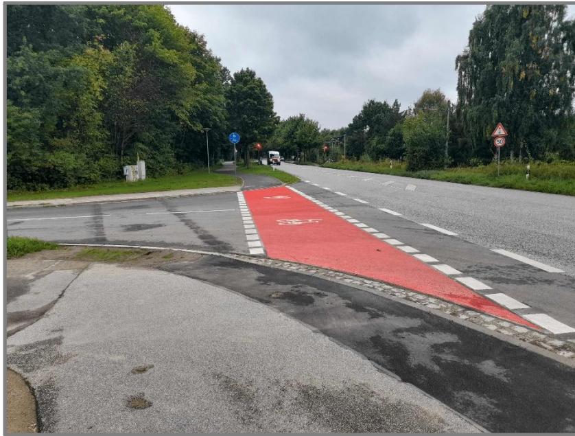
Abb: Travemünder Landstraße/Elbingstraße, Verlegung Zweirichtungsradweg
