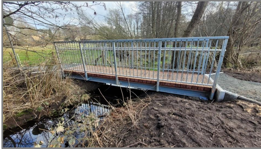
Abb.: Fußgängerbrücke Blankensee
