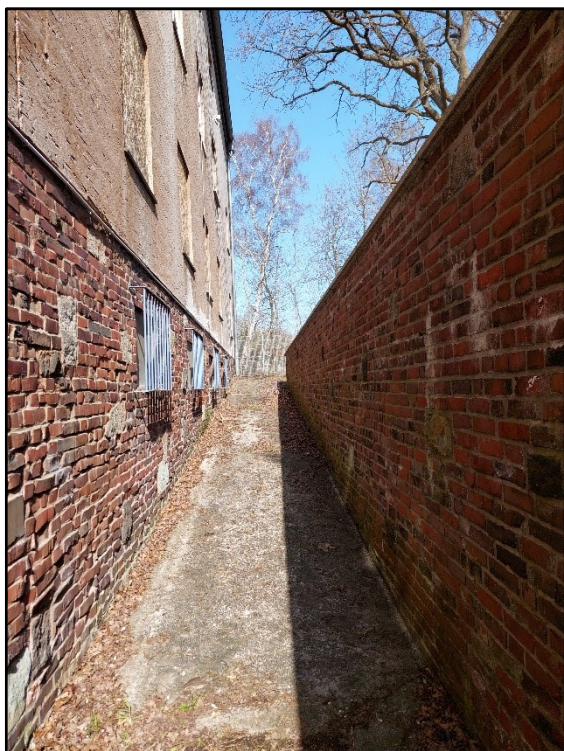
Kellerzugang (Blick von unten)
