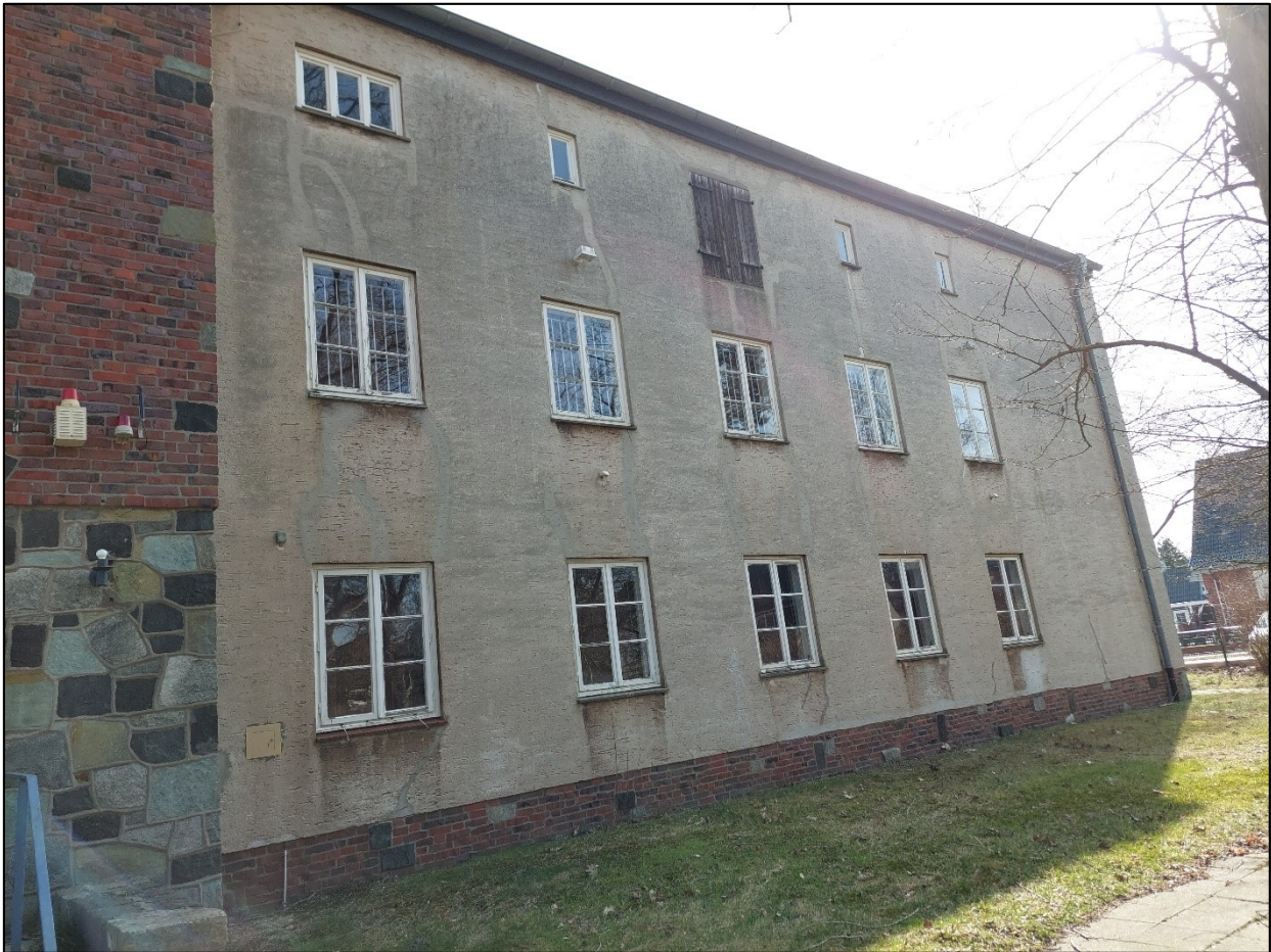
Rechtes Gebäude; Außenfassade
