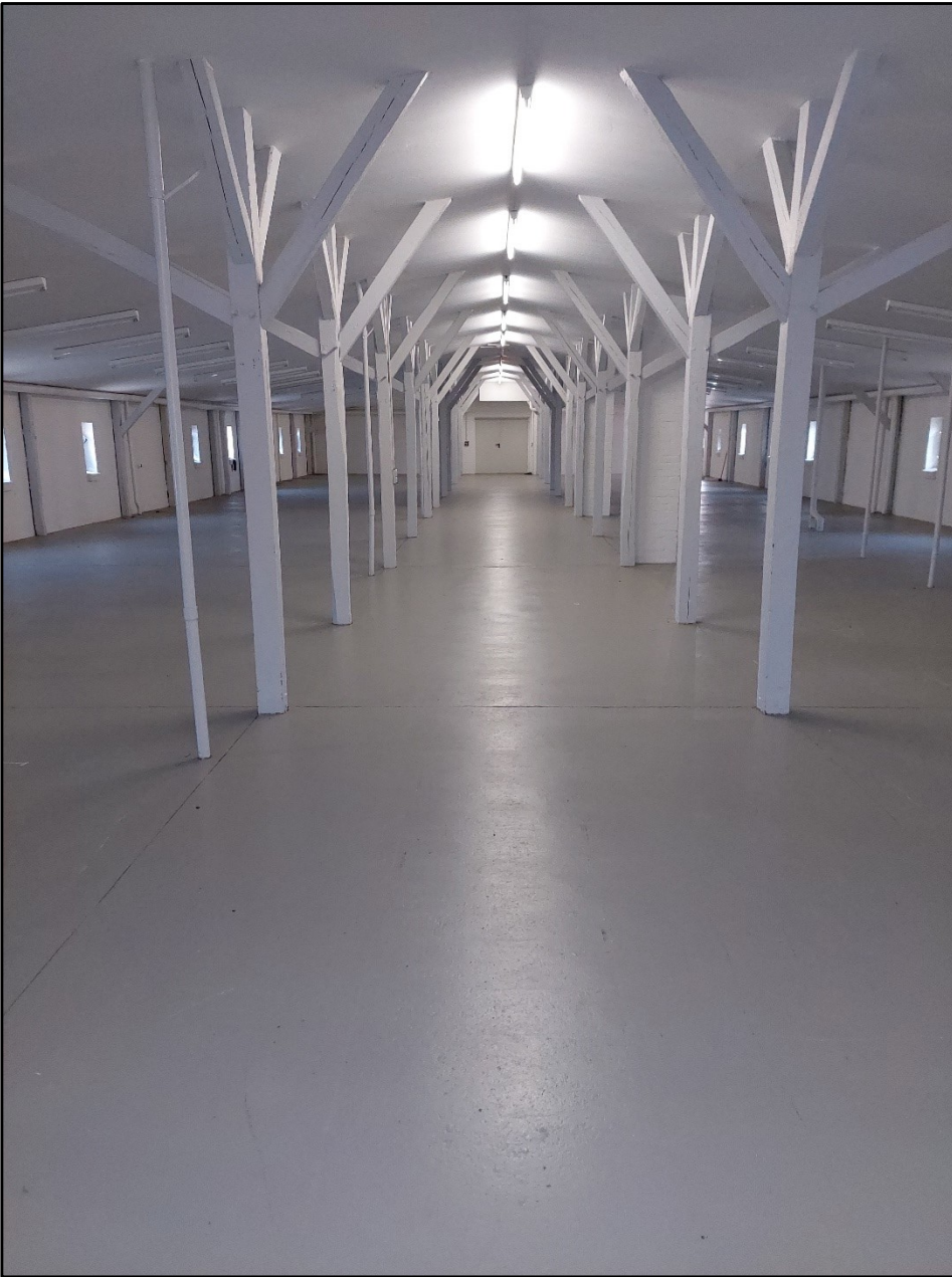
Dachgeschoss; rechten Gebäude
