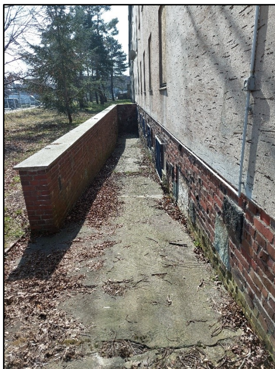
Kellerzugang (Blick von oben)
