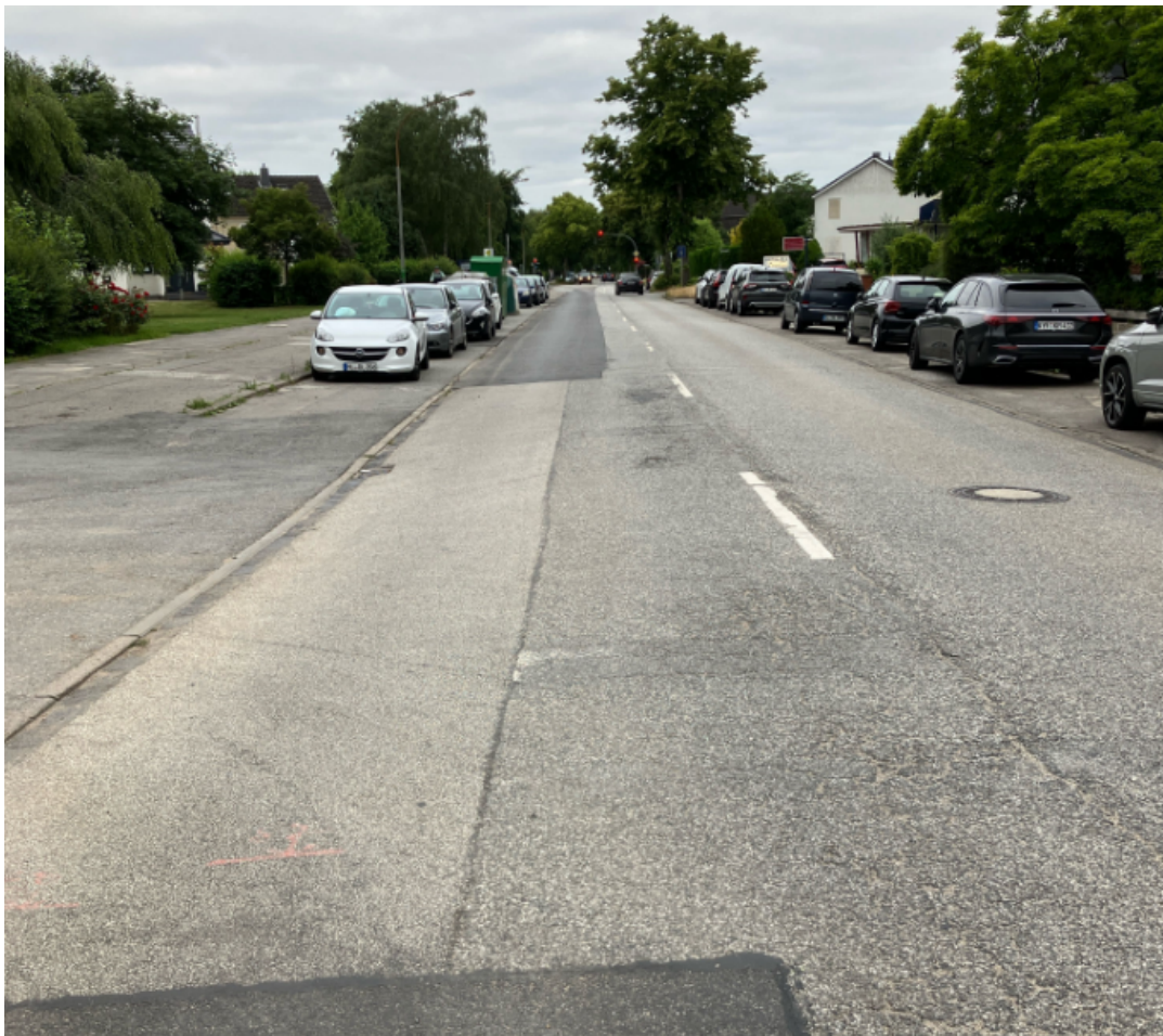
Abb. 1 Aktueller Zustand Schönböckener Straße
