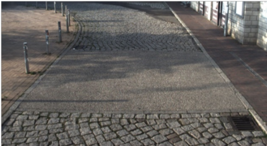
Abbildung 2: Querung in Asphalt
