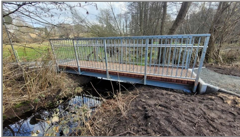
Abb.: Fußgängerbrücke Blankensee
