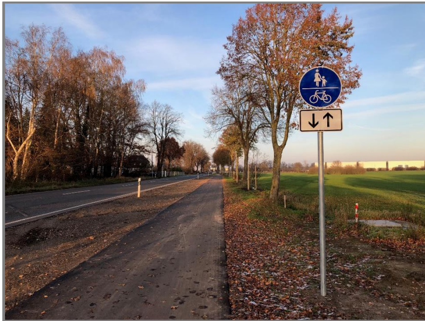
Abb.: Kronsfordener Landstraße L92 (Bau durch Landesbetrieb Straßenbau und Verkehr)
