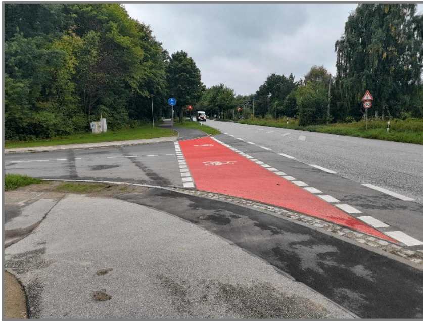
Abb: Travemünder Landstraße/Elbingstraße, Verlegung Zweirichtungsradweg
