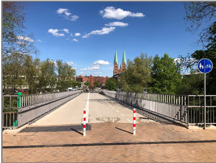
Abb.: Stadtgrabenbrücke für Fuß- und Radverkehr
