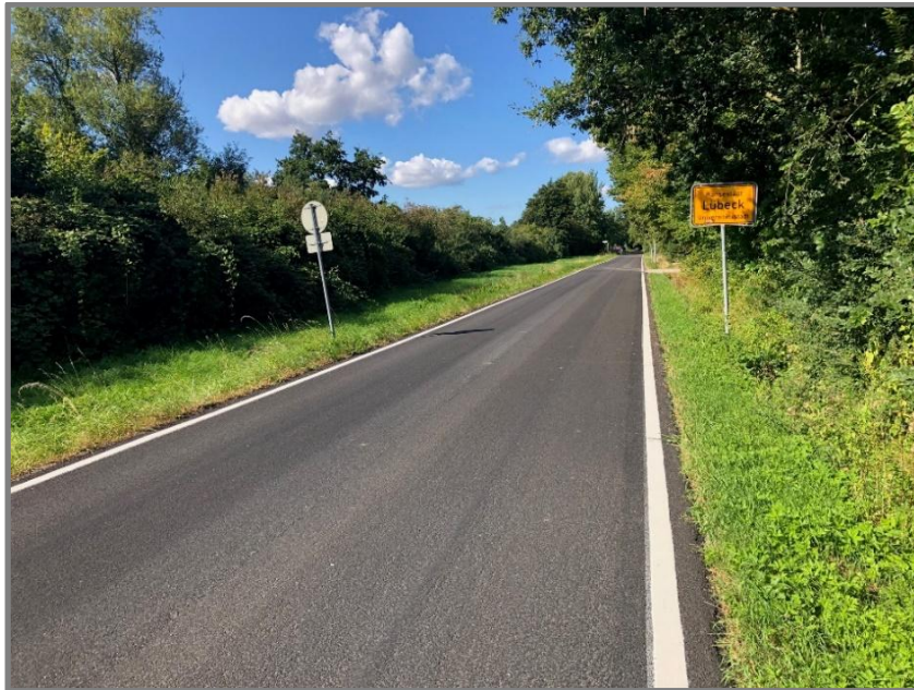
Abb.: Sanierung der Vorrader Straße K8
