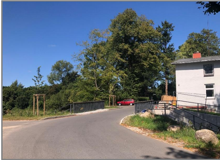
Abb.: Brücke Brandenmühle/Eckbusch über die Grienu
