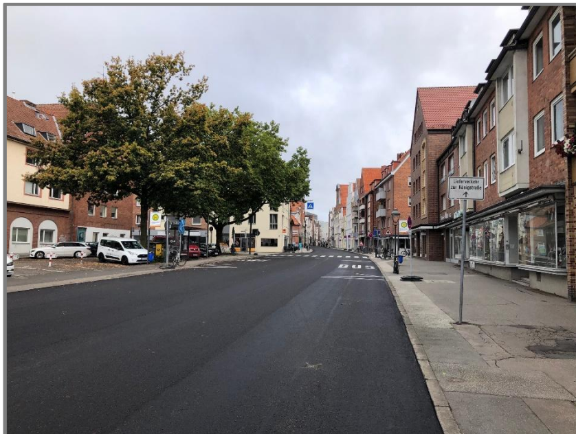
Abb.: Sanierung der Krähenstraße
