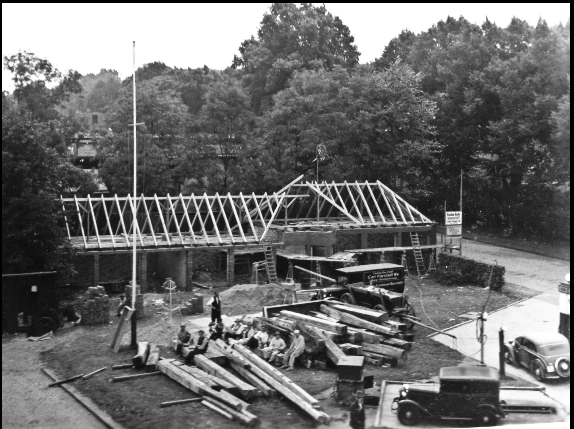
Fa. Schulze und Oltmanns: Tankstelle und Garagen am Holstentor, 1936
