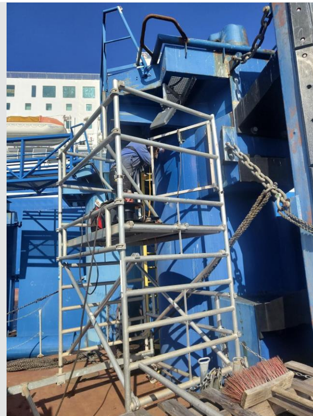
Fenderreparatur am Skandinavienkai
