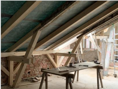
Dachgeschoss während des Ausbaus
