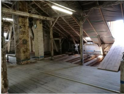
Dachgeschoss vor Ausbau
