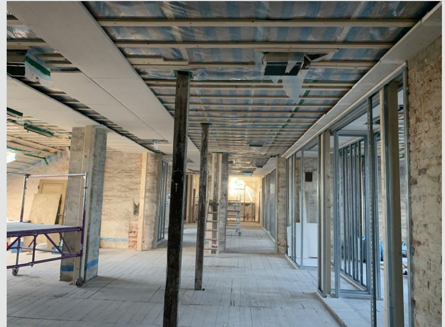
Dachgeschoss - im Bau
