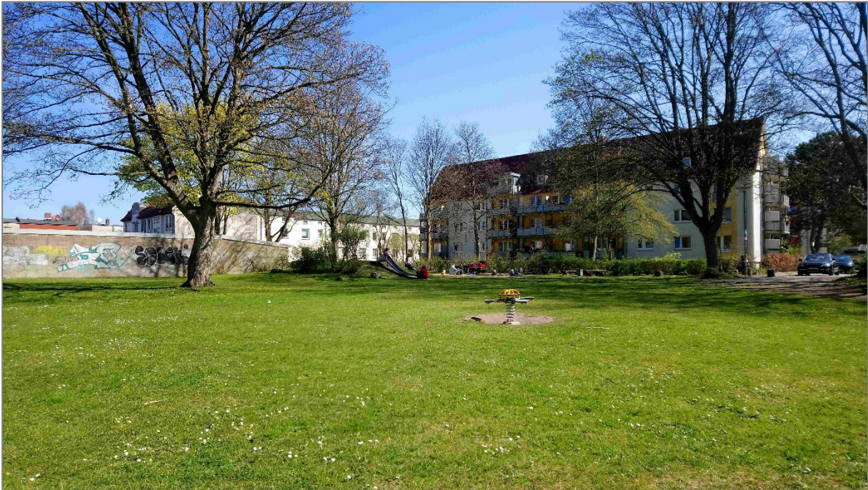
Abb. 1: KSP Schenkendorfstraße - derzeitige Situation
