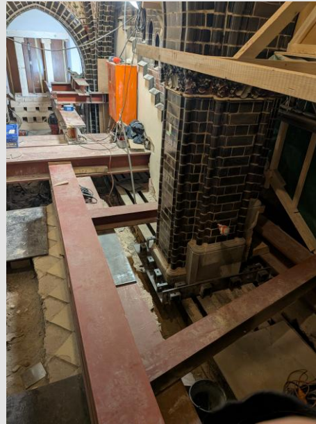
Bild 10 | Provisorische Abfangkonstruktion
