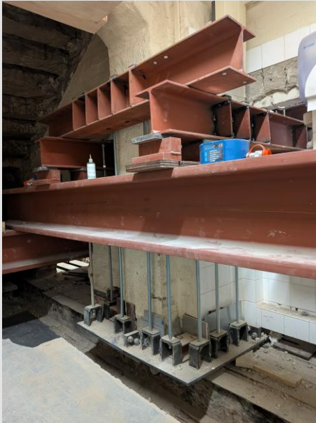
Bild 9 | Stütze im Traggerüst
