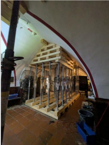
Bild 11 | Sicherheitsabstützung im Ratskeller ( ● unter Treppenhausestützen)
