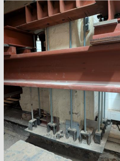
Bild 8 | Anheben der Stütze
