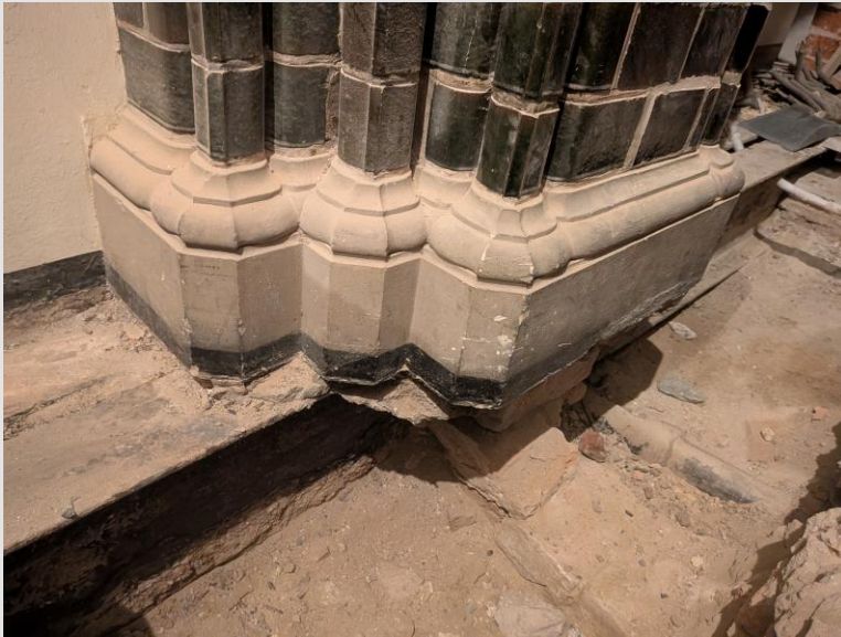
Bild 5 | Stütze auf Stahlprofilen
