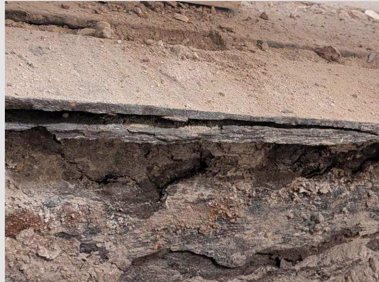
Bild 6 | Detail stark korrodiertes Stahlprofil
