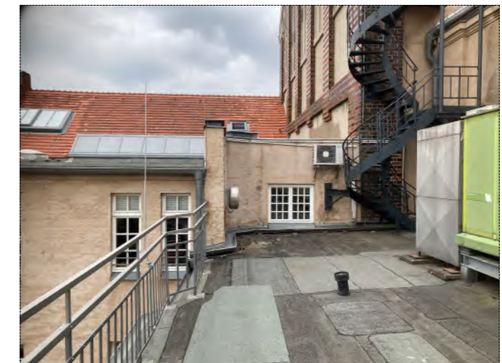
Foto: Dach 5 mit Fluchttreppe
