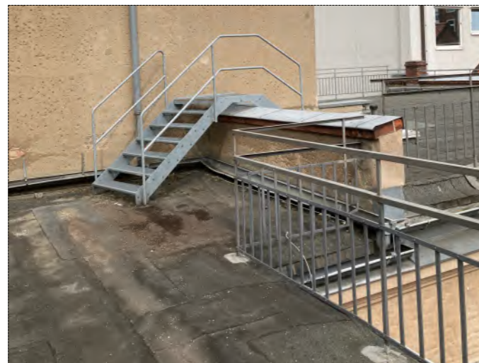
Foto: Übergang zwischen Dach 11 und 10
