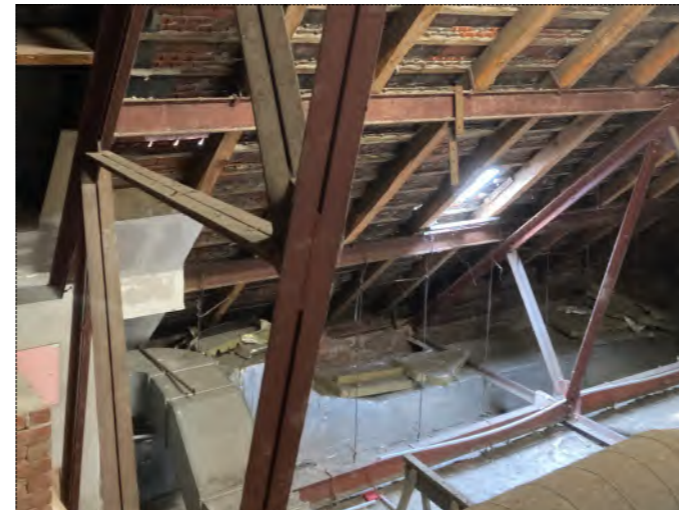
Foto: Dachinnenraum über Mittelrangfoyer
