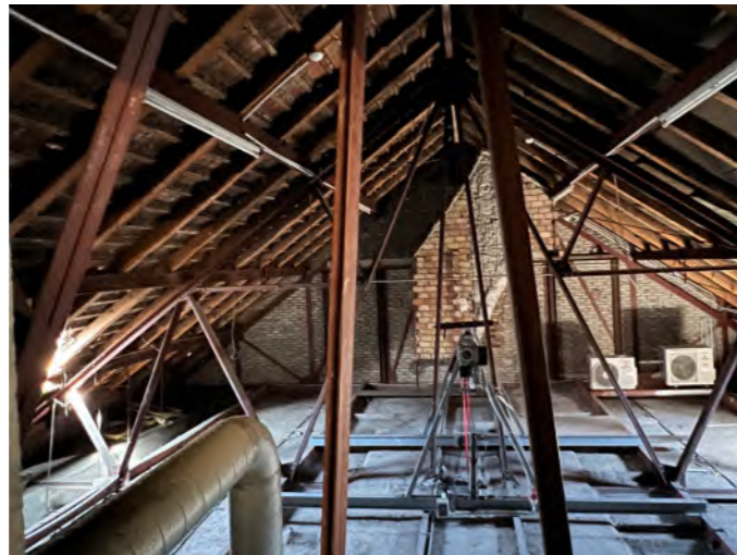
Foto: Dachinnenraum über Mittelrangfoyer
