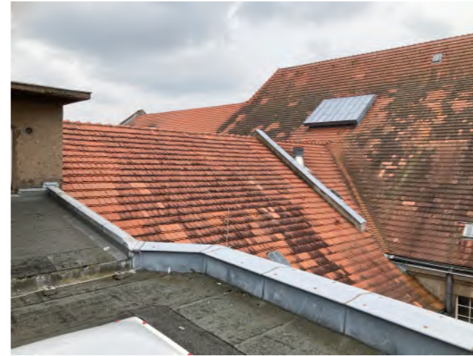
Foto: Dach 16.3 Dachraum über über Mittelrangfoyer
