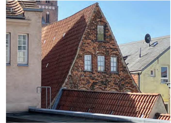
Foto: Dach 16.1 und 16.2 Bauteil 4
