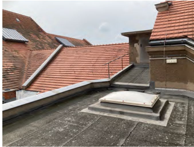
Foto: Dach 16.3 Dachraum über Mittelrangfoyer
