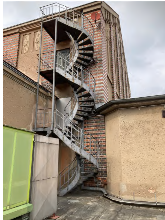
Foto: Fluchttreppe Dach 11
