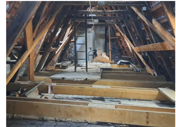
Foto: Dachinnenraum Bauteil 4
