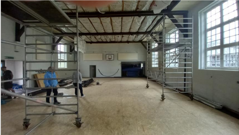
Foto: Die untere Verkleidung und Reste der alten Deckenheizung sind zur Entlastung rückgebaut (Stand 16.07.2025)
