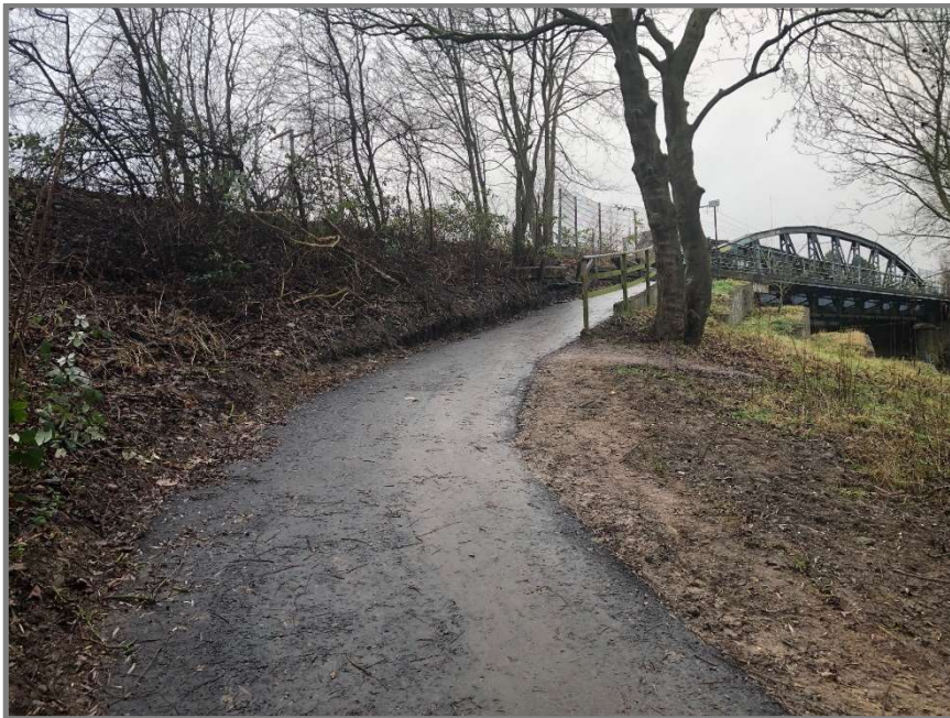
Abb.: Rampe Eisenbahnbrücke Genin
