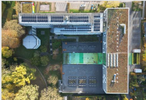
Baltic-Schule, 62 kWp PV-Anlage auf Hauptgebäude
