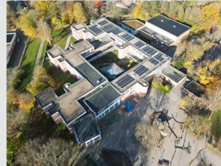
Baltic-Schule, 62 kWp PV-Anlage auf Hauptgebäude
