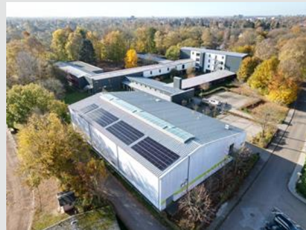
Thomas-Mann-Schule, 38 kWp PV-Anlage auf Sporthalle
