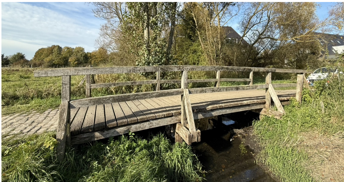
Abb. 2: Seitenansicht (Quelle: HL, 5.660)
