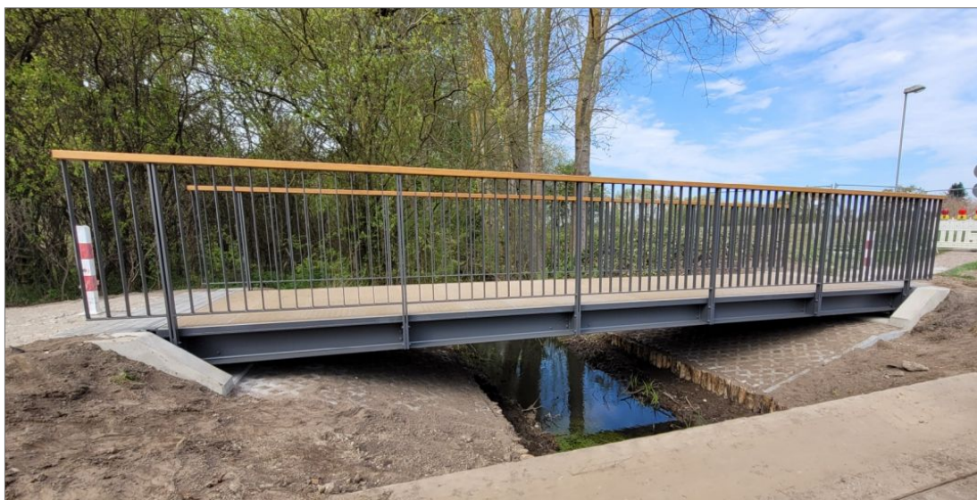
Abb. 4: Beispielbild BW 103 G-R-Brücke Mori (baugleich zur geplanten G-R-Brücke Dornbreite)
