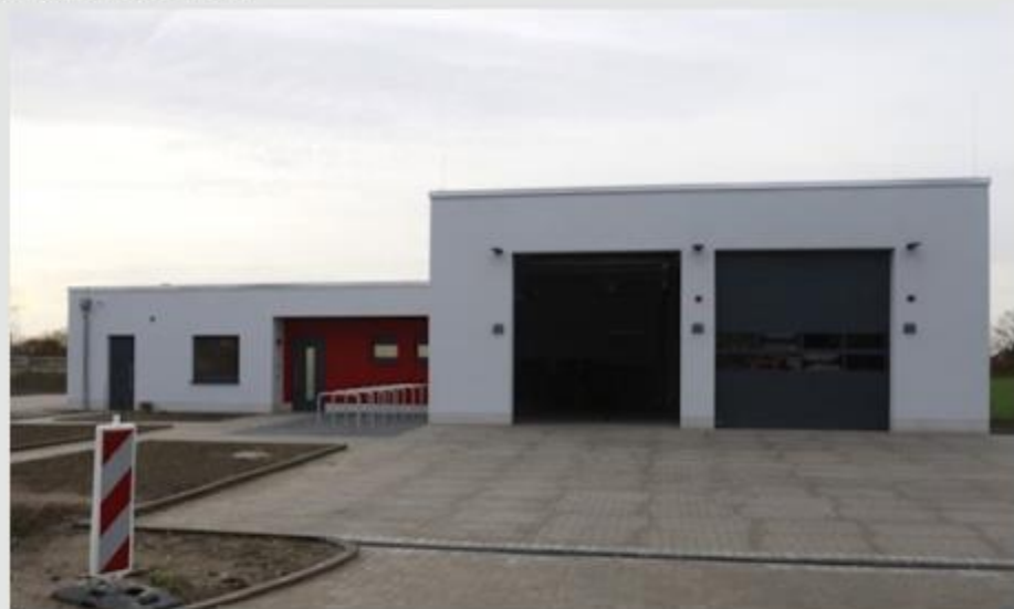
Baubeginn 2023, Einweihung Anfang 2025
