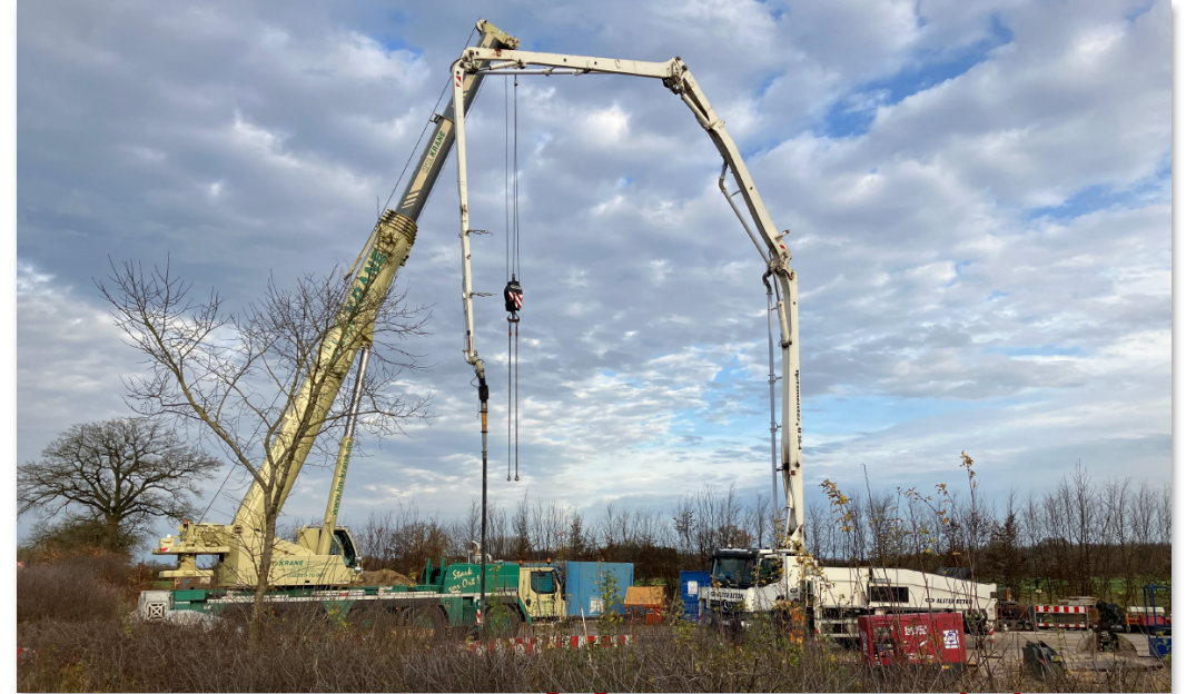
Einbau Unterwasserbeton
