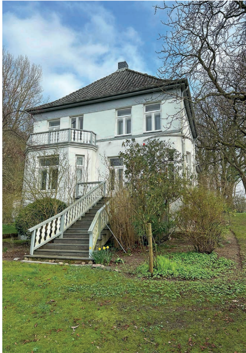
Treppe in den Garten
