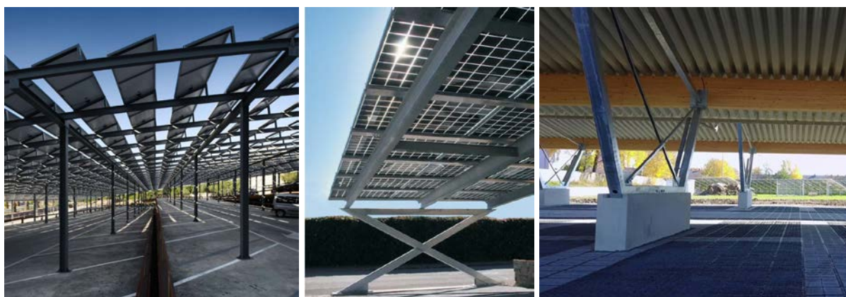
Abbildung 60: PV-Parkplatzüberbauung mit geneigten Modulen ohne Dachfunktion, Universität in Murcia (Links, Foto: ecoprojecta.es), PV-Stellplatzüberdachung, Dachfunktion durch PV-Module (Mitte, Foto: ClickCon), PV-Stellplatzüberdachung, Dachfunktion durch Blechdach (Rechts, Foto: PMT)
