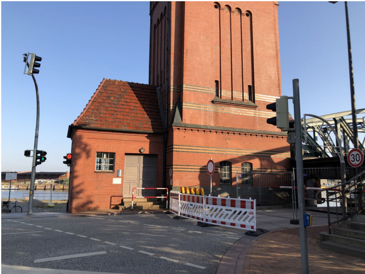
Südliches Hubbrückengebäude von Osten (Kanalstraße) gesehen
