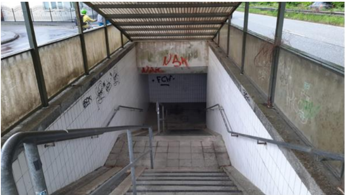
Abbildung 17 Unterführung an der Haltestelle Jungborn (Quelle: Hansestadt Lübeck)
