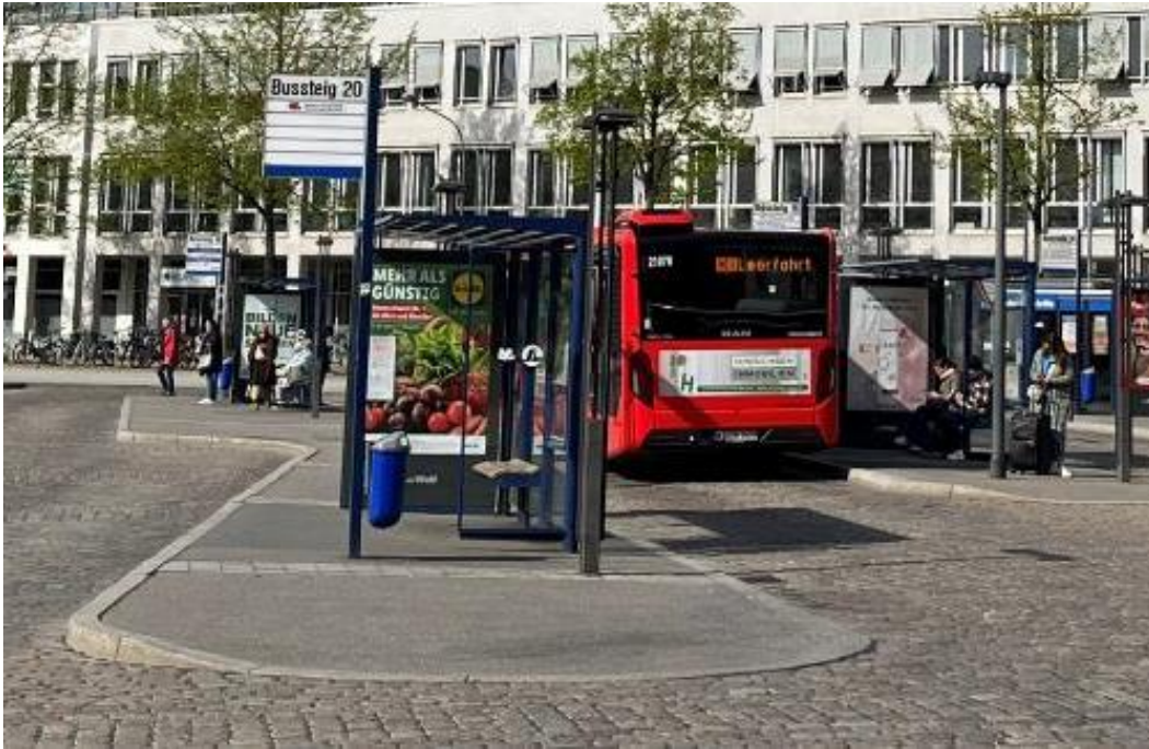
Abbildung 15 Beispiel ZOB, Erneuerung von Fahrgastunterständen (Quelle: Aufnahme Ramboll)
