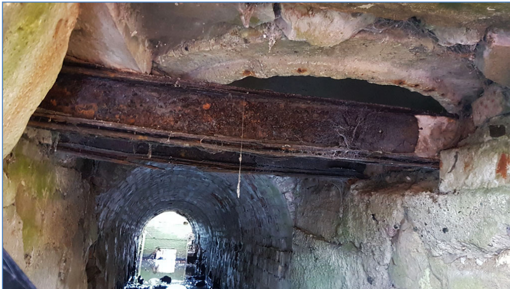
Abb. Innenansicht mit Trägern unter dem Wandfundament
