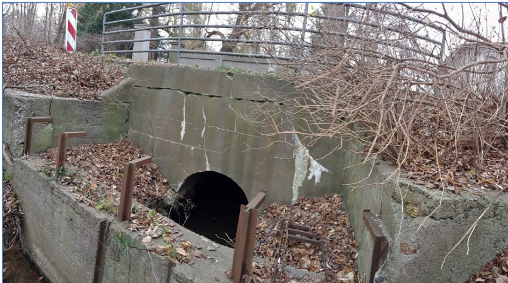
Abb. Ansicht von Vorn, Zulauf DL Brandenmühle
