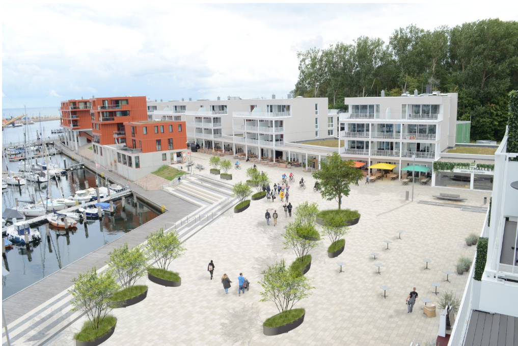
Solitär auf dem zentralen Marktplatz und verteilte Kübel auf der Platzfläche
