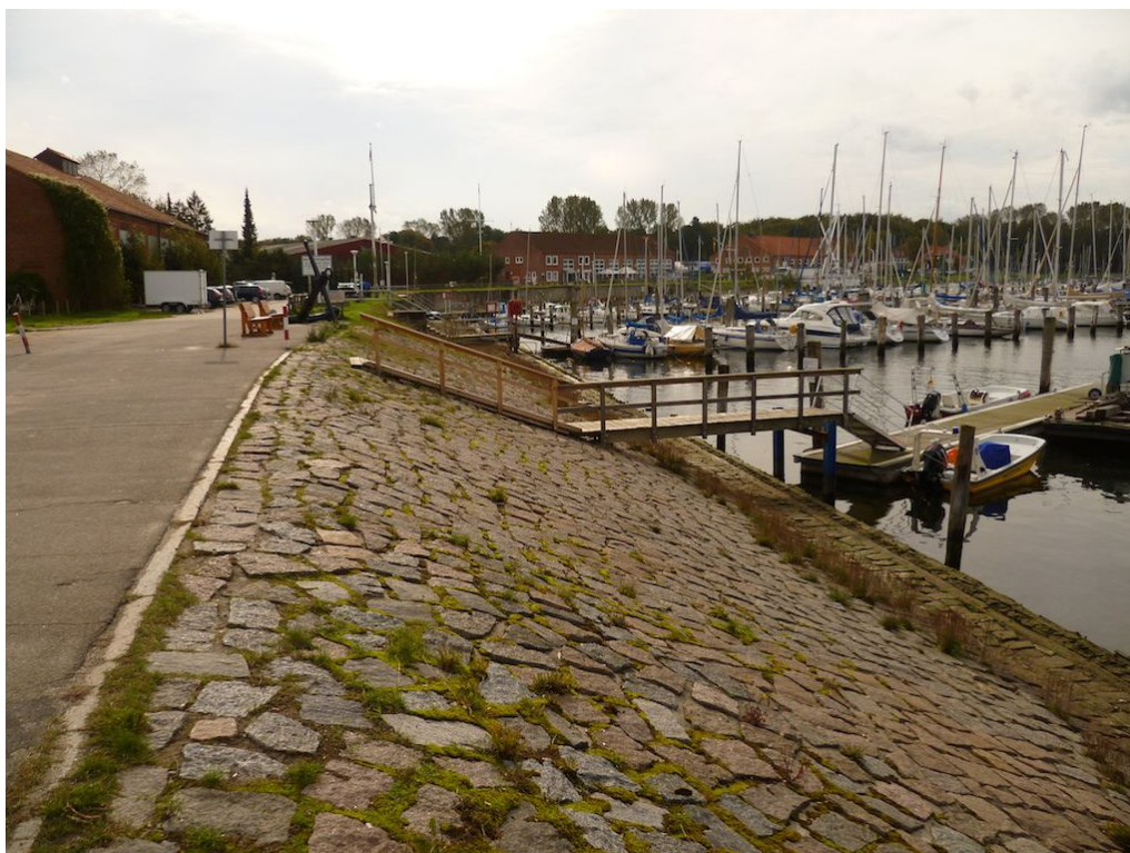
Gesetztes Deckwerk am Passatplatz mit Holzspundwand im Jahr 2013
