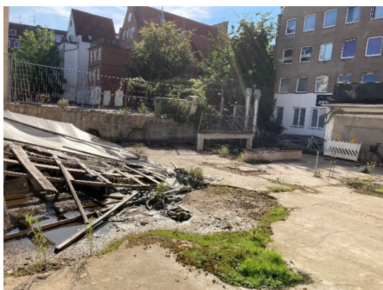
Dachfläche Gebäude Mengstraße 12-14
