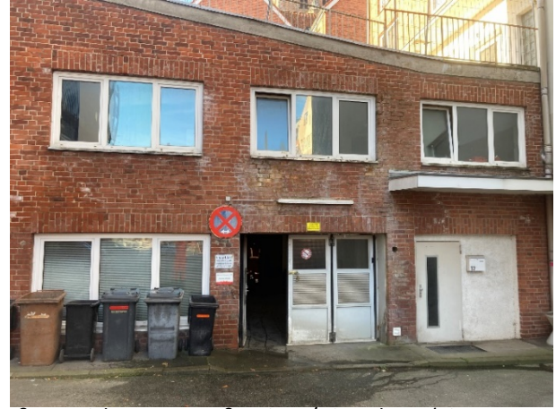
Außenansicht Mengstraße 12-14/Hinterhaus (Ein-
