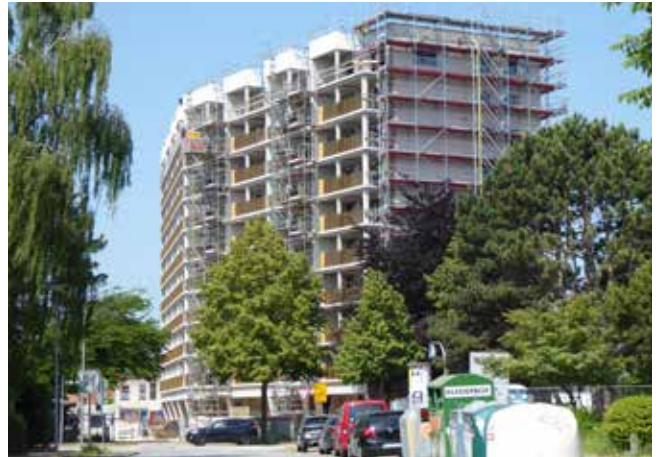
Abb. 37: Sanierungsmaßnahme Hochhaus Sterntalerweg 1-3 (Juni 2023)
