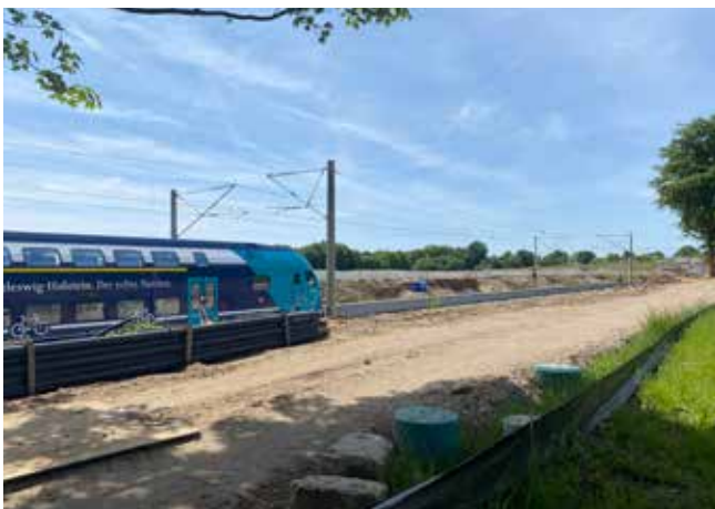
Abb. 39: Baumaßnahme Bahnhofsteilpunkt Moisling (Juni 2023)
