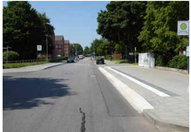
Abb. 122: Abgeschlossene Straßensanierung Moislinger Mühlenweg
