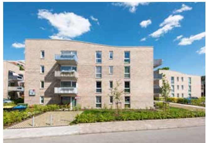
Abb. 74: Neubauvorhaben „7 Moisinge“ im Schneewittchenweg
