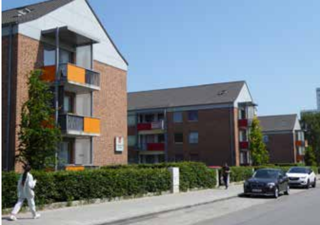
Abb.68: Neubauähnliche Sanierung im Moisinger Mühlenweg
