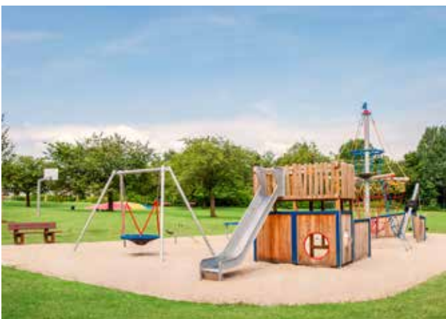
Abb. 35: Anlage nach Fertigstellung
