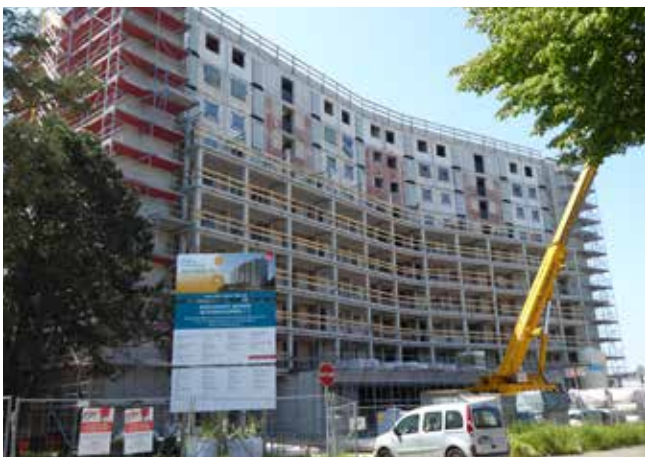
Abb. 44: Sanierungsmaßnahme Hochhaus Sterntalerweg 1-3 (Juni 2023)
