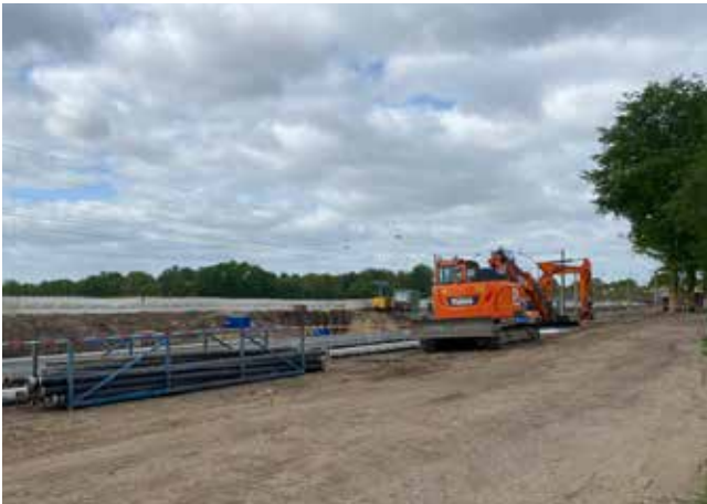
Abb. 121: Baumaßnahme Bahnhofpunkt Moisling (Juni 2023)
