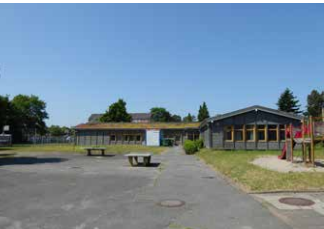
Abb. 104: Leerstehender Pavillon - Grundstück für den Kita-Neubau
