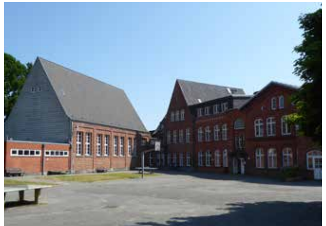
Abb. 103: Alte Schule Moisling und Turnhalle (linkes Gebäude) Hofansicht
