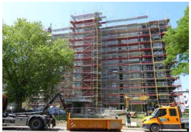
Abb. 38: Sanierungsmaßnahme Hasselbreite 3 (Juni 2023)
