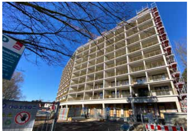
Abb. 108: Sanierungsmaßnahme Sterntalerweg 1-3 der TRAVE
