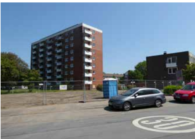
Abb. 111: Moislinger Mühlenweg - Bereich des künftigen Stadtteilplatzes
