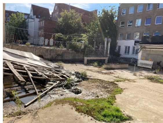
Dachfläche Gebäude Mengstraße 12-14
