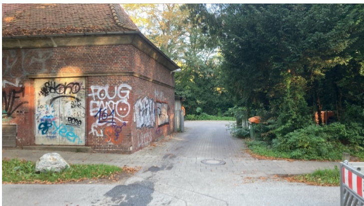
Außenansicht Gebäude Hüntertorallee
