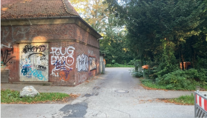
Außenansicht Gebäude Hüntertorallee
