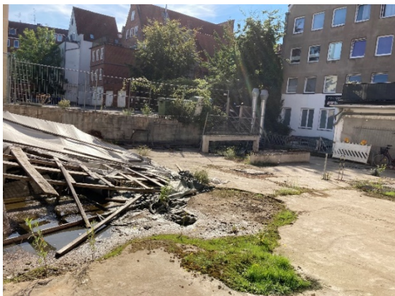
Dachfläche Gebäude Mengstraße 12-14
