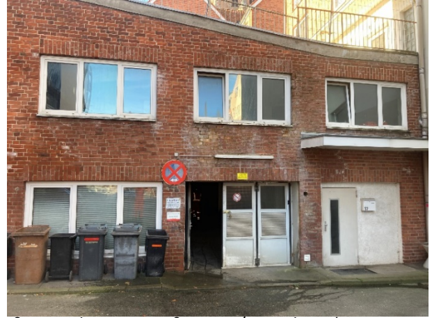
Außenansicht Mengstraße 12-14/Hinterhaus (Ein-
