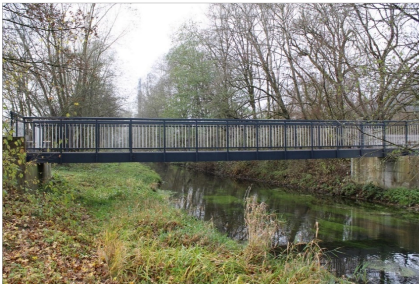
Abb. 4: Beispiel einer GFK-Brücke (BGL Ing.-Bau GmbH)
