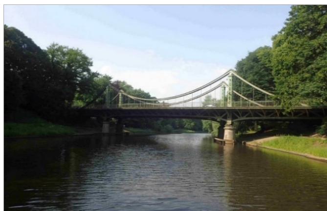
Abb. 1: Seitenansicht (2021, Blickrichtung Possehlbrücke)
