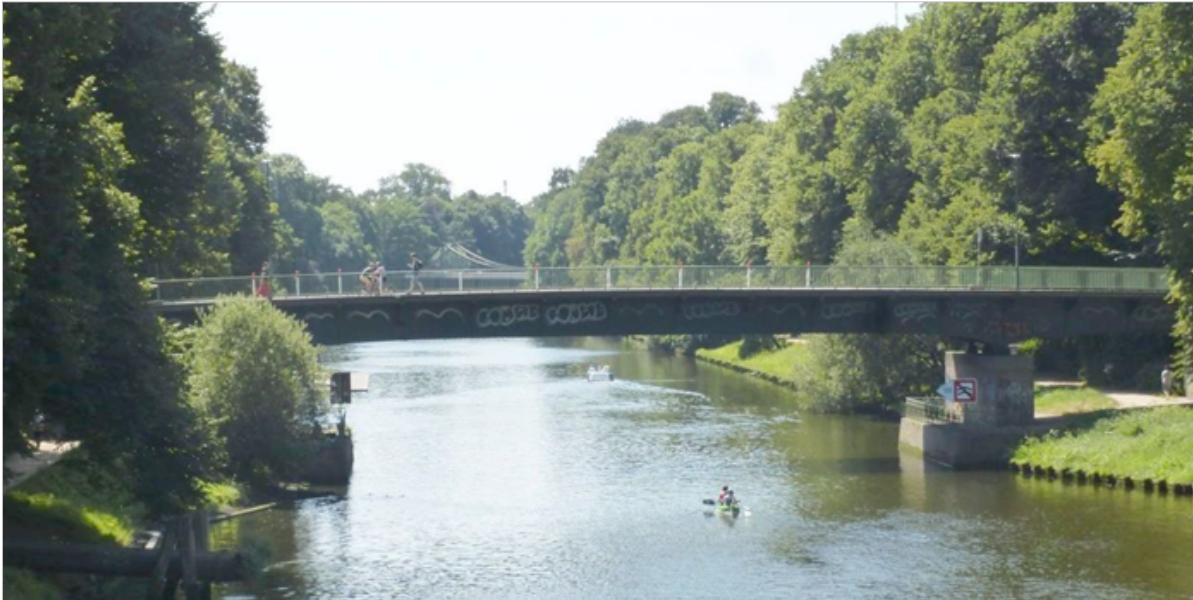
Abb. 2: Seitenansicht Rehderbrücke (Quelle: HL, 5.660)
