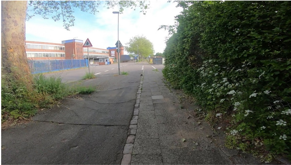
Straße: Glashüttenweg, Abschnitt: 1574852 - 1574832, Station: 20, Lage: L, FS: 1
