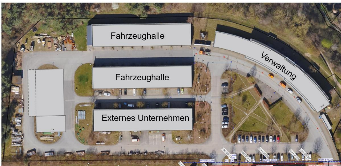
Abbildung 5: Standort der Kanalreinigung (Ratekauer Weg)
