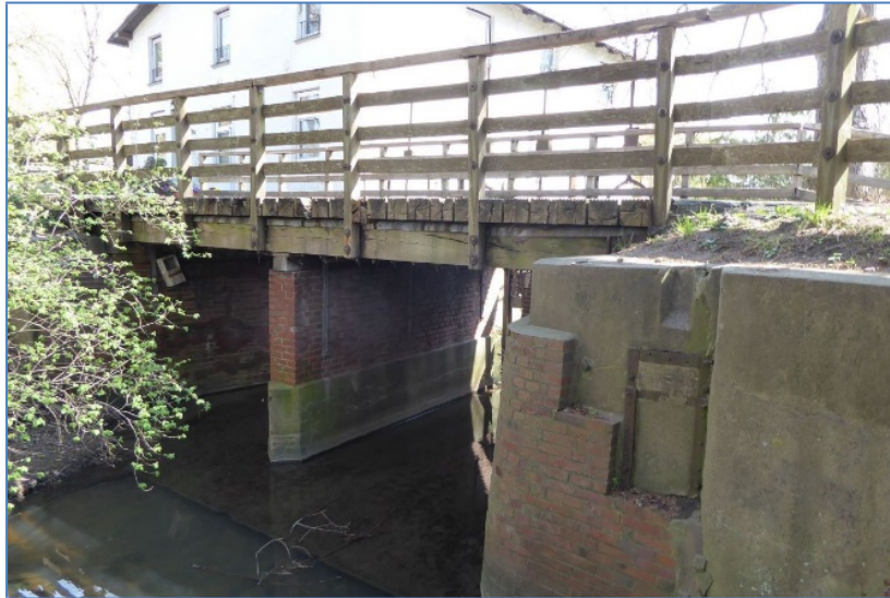
Abb. Seitenansicht Brandenmühle
