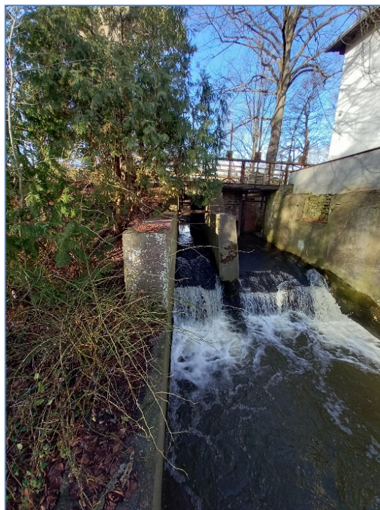
Abb. Seitenansicht mit Absturz- und Trogbauwerk
