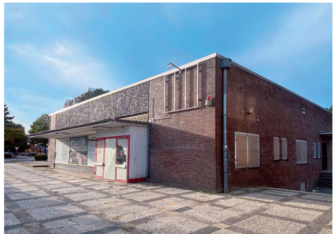
Abb. 11: Leerstehendes Einzelhandelsgebäude / ehemals „Penny-Markt“, Moislinger Mühlenweg 66 (Quelle: Hansestadt Lübeck)
