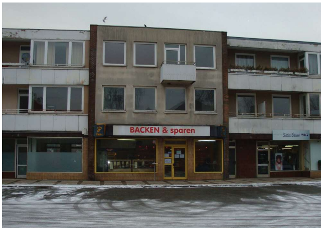
Abb. 12: Wohn- und Geschäftsgebäude Moislinger Mühlenweg 60-64 (Quelle: Hansestadt Lübeck)
