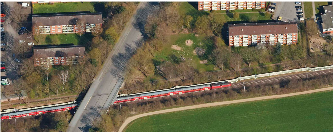
Abb. 27: Ausschnitt Schrägluftbild mit Lärmschutzwand entlang der Bahntrasse (Quelle: Hansestadt Lübeck)
