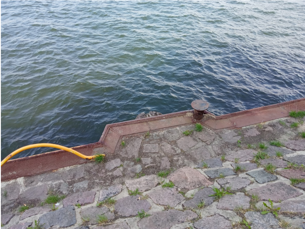
Bild 13: Spundwandholm, Detail Bereich Steigeleiter und Reibepfahl
