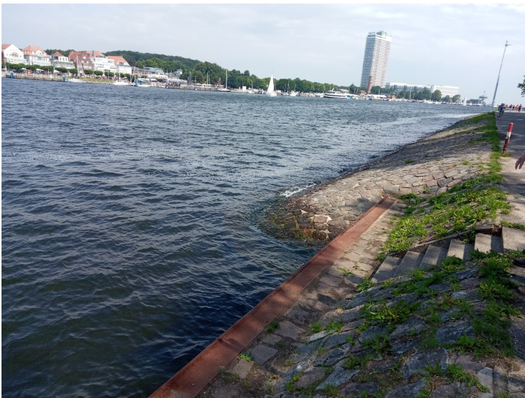
Bild 14: Übergang Spundwand mit Deckwerk zu Deckwerk ohne Spundwand
