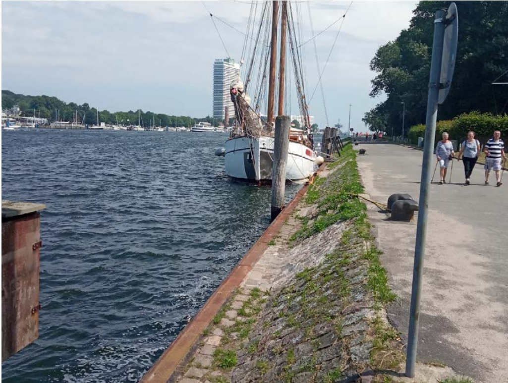
Bild 11: Ufereinfassung mit Spundwand und Deckwerk (Bereich I), Promenadenweg
