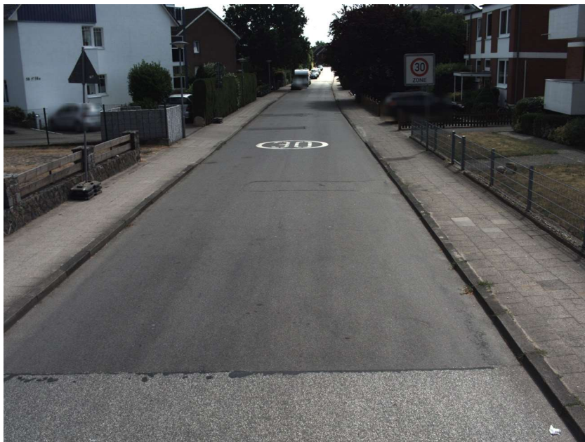
Straße: Rose, Abschnitt: 2582804 - 2581814, Station: 11, Lage: R, FS: 1
