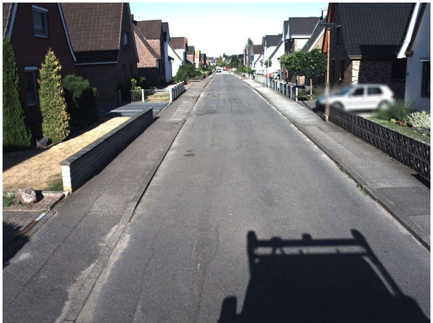
Straße: Hudestrasse, Abschnitt: 2276801 - 2276823, Station: 47, Lage: R, FS: 1
