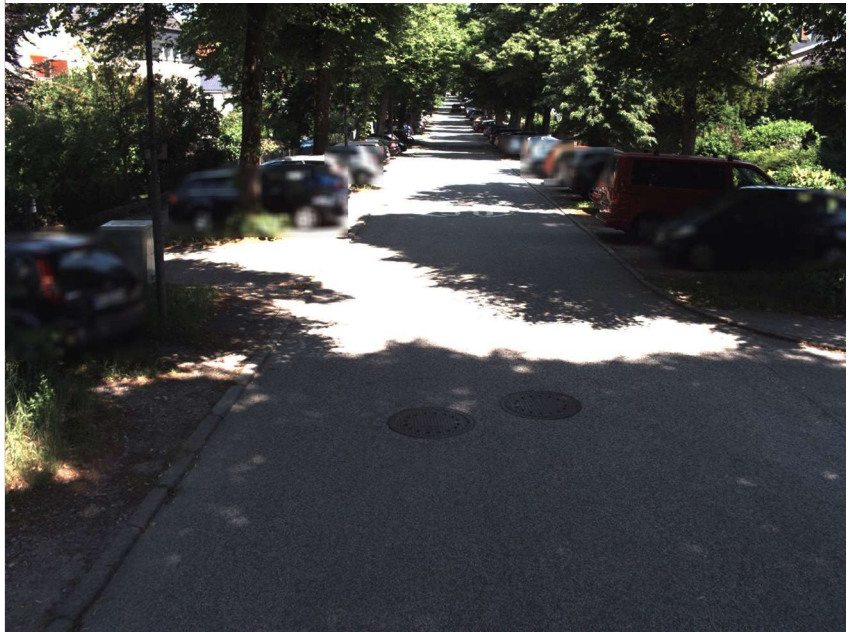
Straße: Eschenburgstrasse, Abschnitt: 1473815 - 1473809, Station: 117, Lage: R, FS: 1
