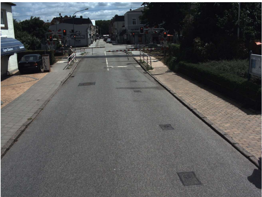
Straße: Rose, Abschnitt: 2581862 - 2581858, Station: 16, Lage: R, FS: 1
