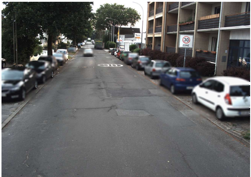
Straße: Kastanienallee, Abschnitt: 1469855 - 1569901, Station: 139, Lage: R, FS: 1
