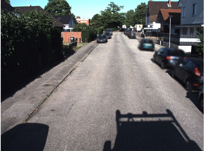
Straße: Rehsprung, Abschnitt: 2176830 - 2176831, Station: 20, Lage: R, FS: 1
