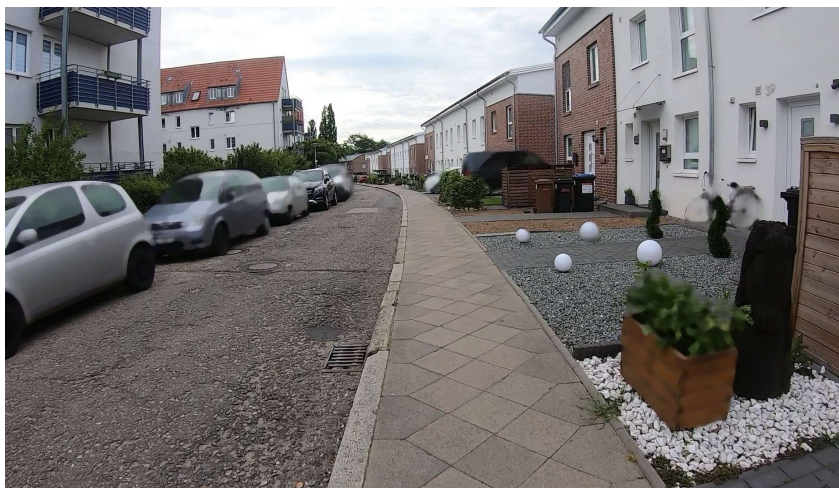
Straße: Bergenstrasse, Abschnitt: 1171839 - 1171840, Station: 55, Lage: R, FS: 1
