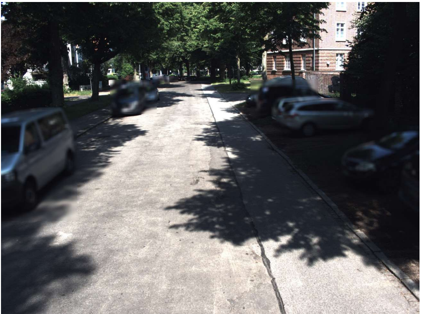
Straße: Von-Morgen-Strasse, Abschnitt: 1570804 - 1570901, Station: 60, Lage: R, FS: 1
