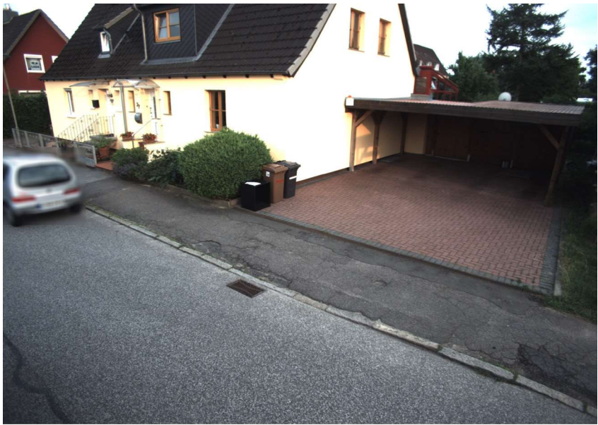
Straße: Adalbert-Stifter-Strasse, Abschnitt: 1468816 - 1468817, Station: 44, Lage: R, FS: 1
