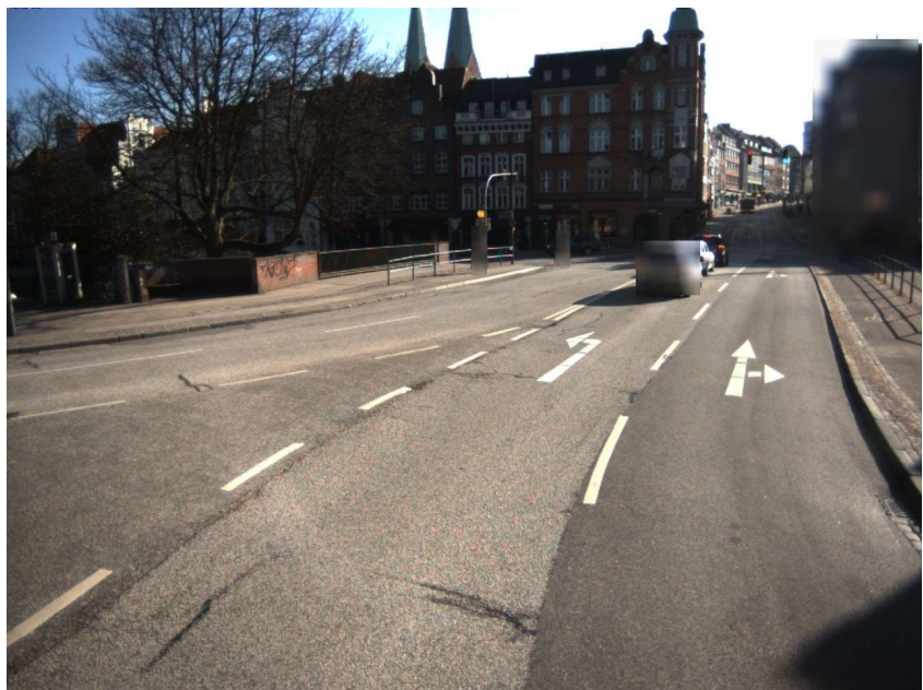
Straße: Holstentorplatz, Abschnitt: 1371916 - 1371987, Station: 48, Lage: R, FS: 1
