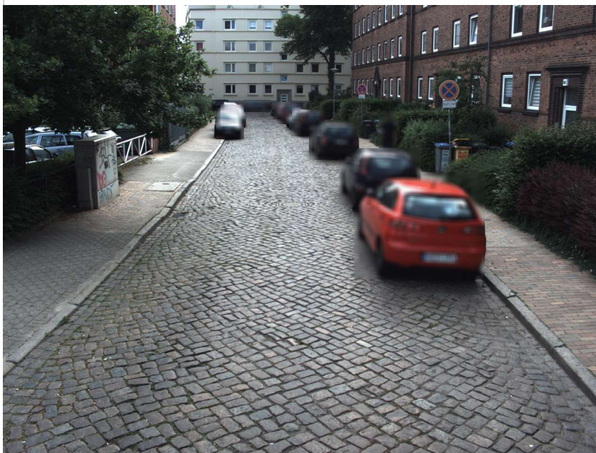
Straße: Lindenstrasse, Abschnitt: 1270829 - 1270820, Station: 77, Lage: R, FS: 1
