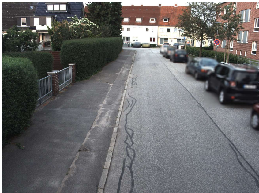
Straße: Sudetenstrasse, Abschnitt: 1468820 - 1468819, Station: 42, Lage: R, FS: 1
