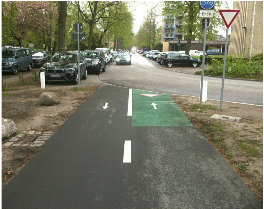
Straße: Eschenburgstrasse, Abschnitt: 1472809 - 1473815, Station: 44, Lage: R, FS: 1
