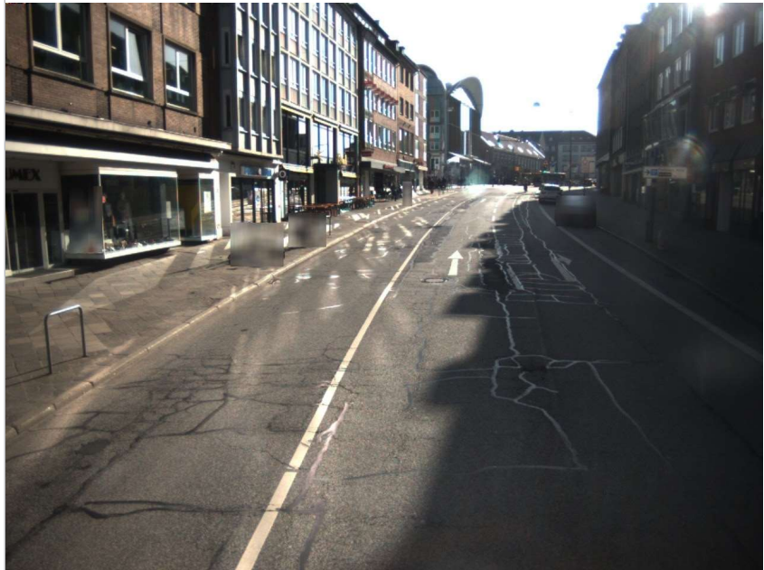
Straße: Holstenstrasse, Abschnitt: 1371907 - 1371841, Station: 35, Lage: R, FS: 1
