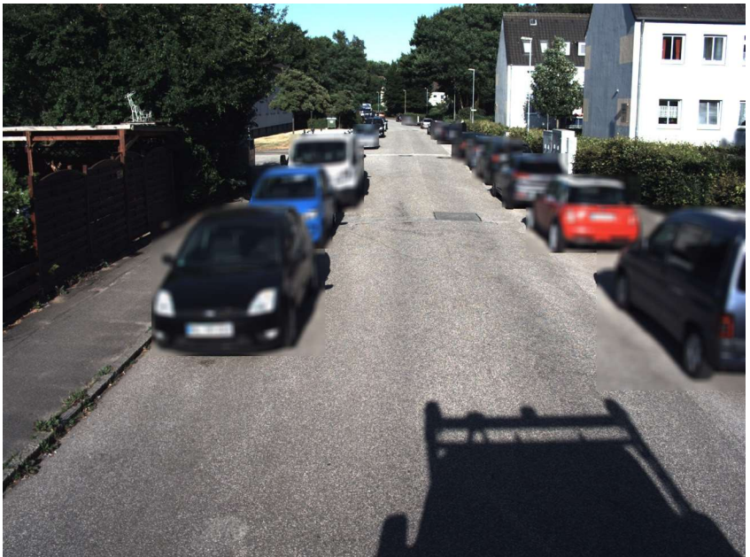
Straße: Rehsprung, Abschnitt: 2176802 - 2176803, Station: 53, Lage: R, FS: 1
