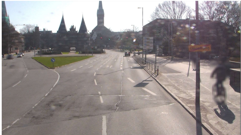
Straße: Holstentorplatz, Abschnitt: 1271912 - 1371922, Station: 43, Lage: R, FS: 1
