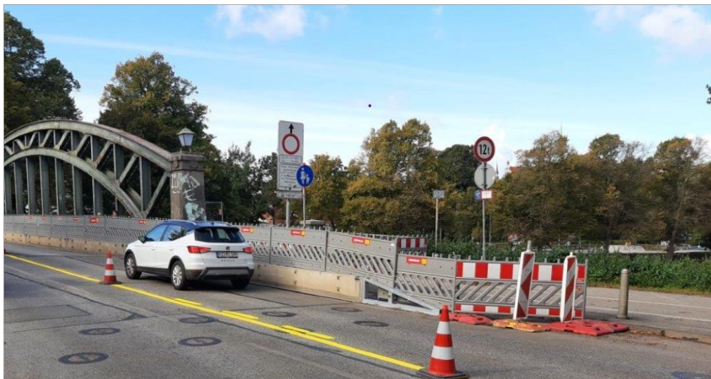
Abb.: BW 007 Hüntertorbrücke – Lastreduzierung
