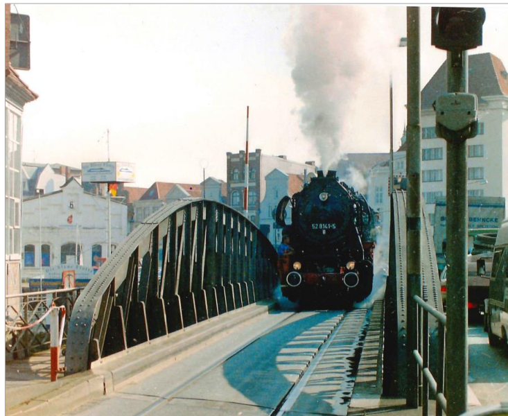
Abb.: Hafendrehbrücke mit Zugverkehr (Quelle: unbekannt)
