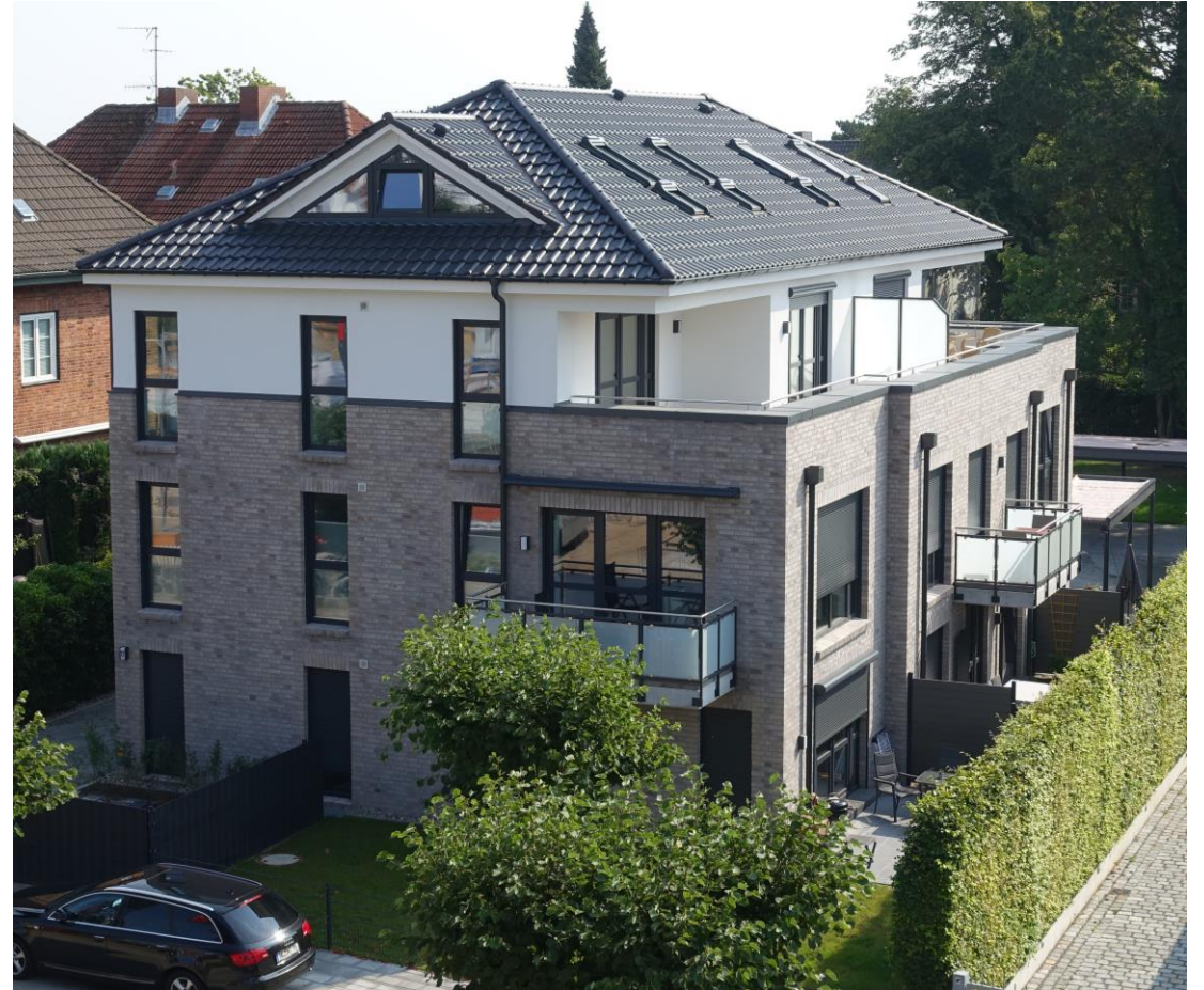
Geschosswohnungen Steuerbord 12, Lübeck- Travemünde
