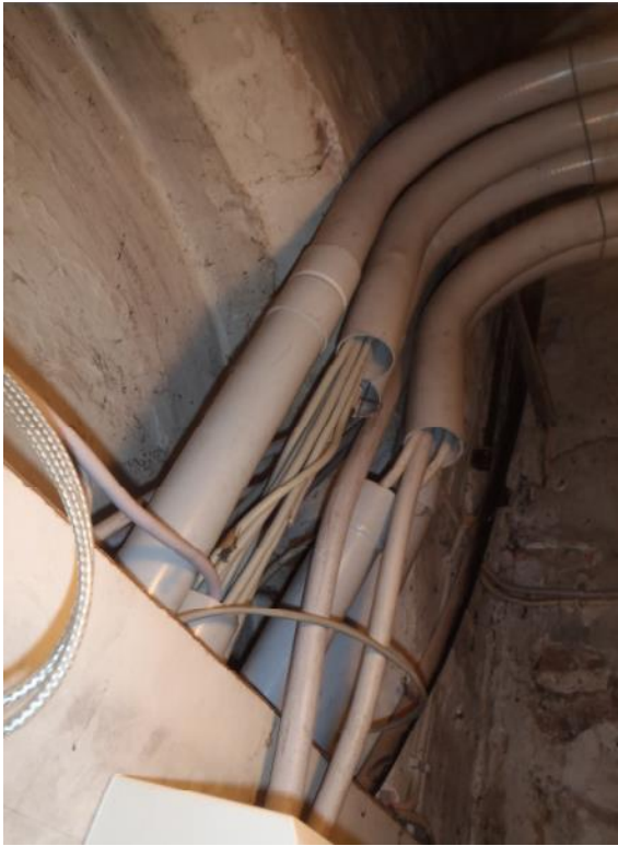
Elektrotechnik: Leitungsführungen und fehlende bzw. nicht fachgerechte Schottungen
