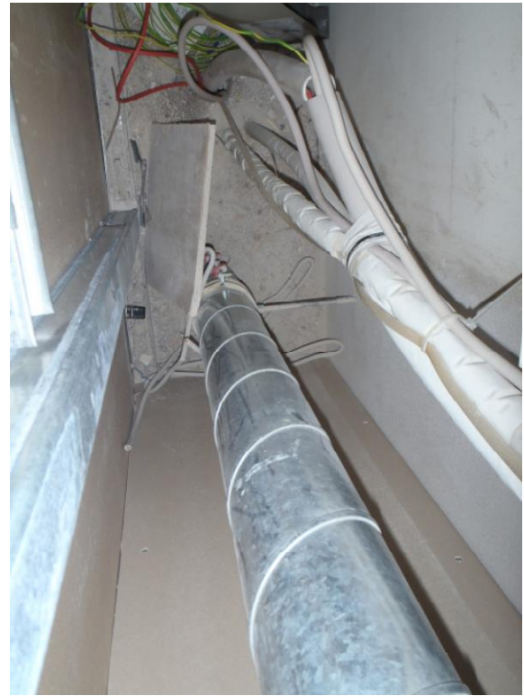
Elektrotechnik: Leitungsführungen und fehlende bzw. nicht fachgerechte Schottungen
