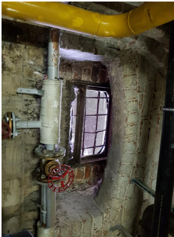
Heizung: Historische Bestandsleitungen
