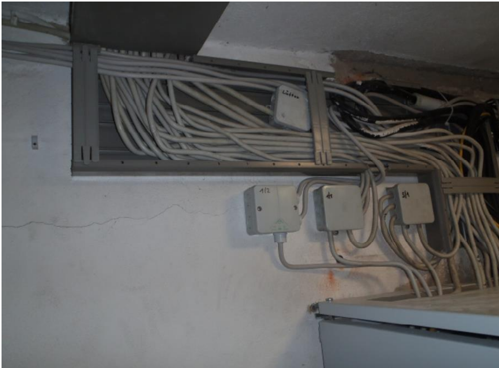
Elektrotechnik: Leitungsführungen / Brandlasten
