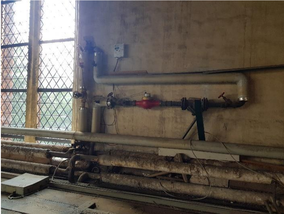
Heizung / Sanitär: Historische Wärmeverteilungsleitungen
