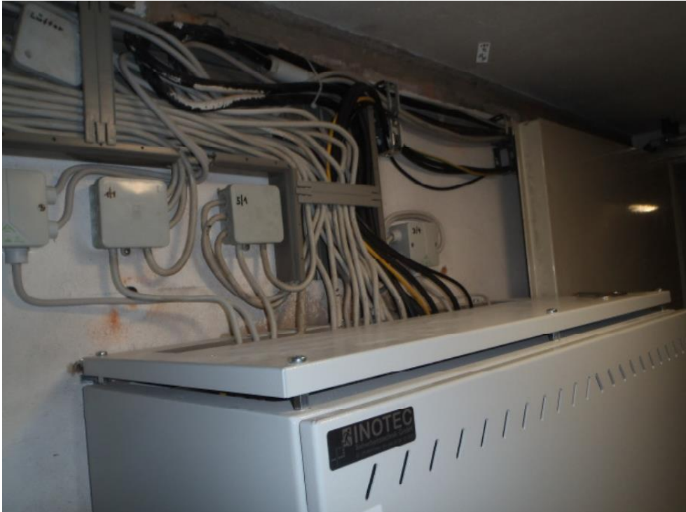
Elektrotechnik: Leitungsführungen / Brandlasten
