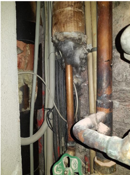
Heizung / Sanitär: Historische Bestandsleitungen (Trinkwasser und Heizung)
