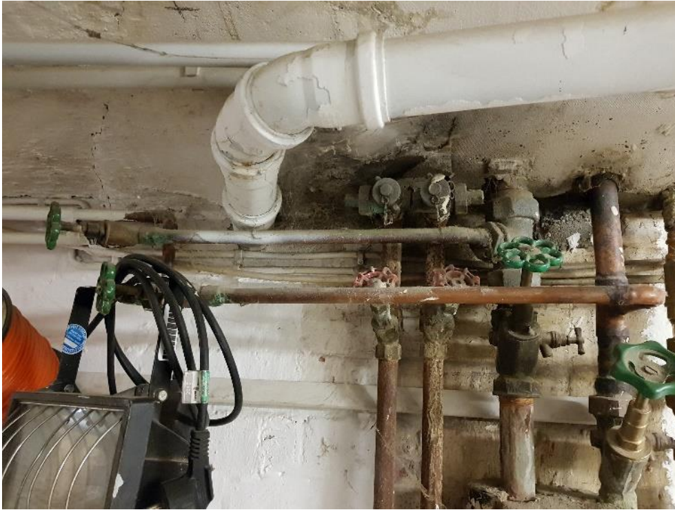
Heizung / Sanitär: Historische Abwasser- und Trinkwasserleitungen
