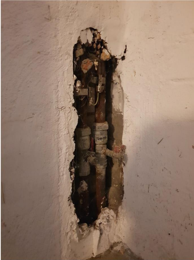
Heizung / Sanitär: Historische Bestandsleitungen (Trinkwasser und Heizung)
