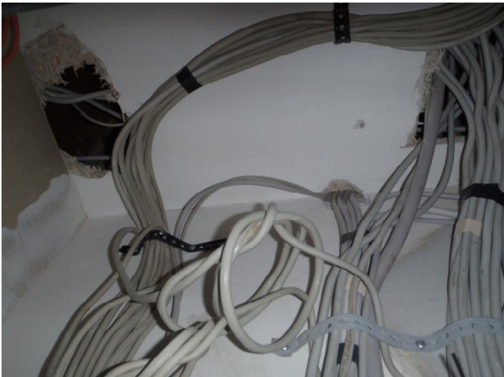
Elektrotechnik: Leitungsführungen / Brandlasten
