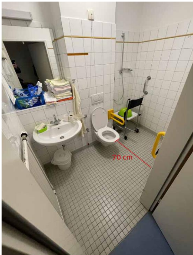
Bewohner-WC: geometrische Einschränkungen aus dem denkmalgeschützten Bauwerk
