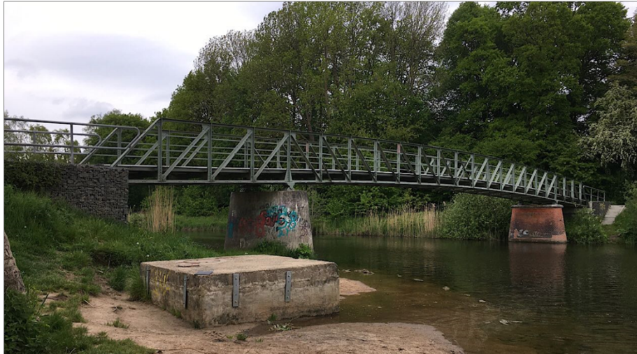
Abb. Seitenansicht Treidelwegbrücke
