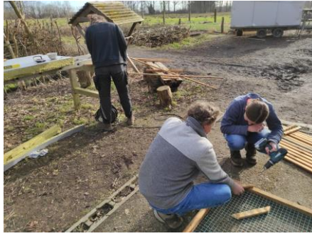
Bau einer Zwischenwand für den Hühnerstall im Februar 2021 (Sarah Winter, Emily Böttner, Alma Rieckmann)
