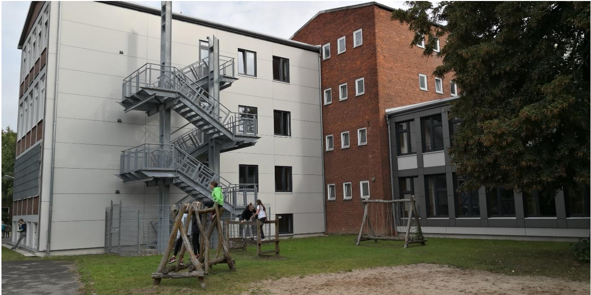
CJB: 4.BA-Trakt 2 mit neuer Fluchttreppe + Teilfassade, Trakt 3 rechts mit Teilfassade
