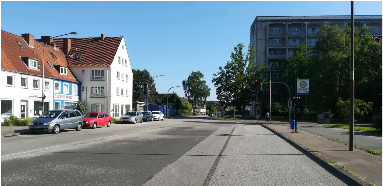
Abb. 3: IST-Zustand Knoten mit Ost- und Westpreußenring – Asphalt auf allen Anlagen bis 28 m Gesamtbreite (Foto: K. Uhlemann 2021)
