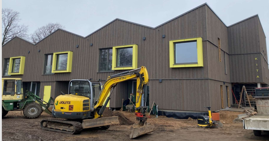
Baustelle Kita Rothebek – DRK, St. Jürgen
